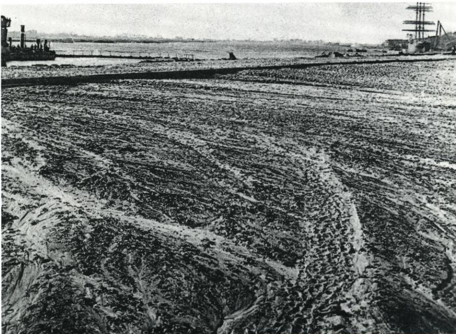
Abb. 4: Baggereinsatz bei der Unterweserkorrektion – Verspülen des Bodens am Ufer (Schwemmapparat)
