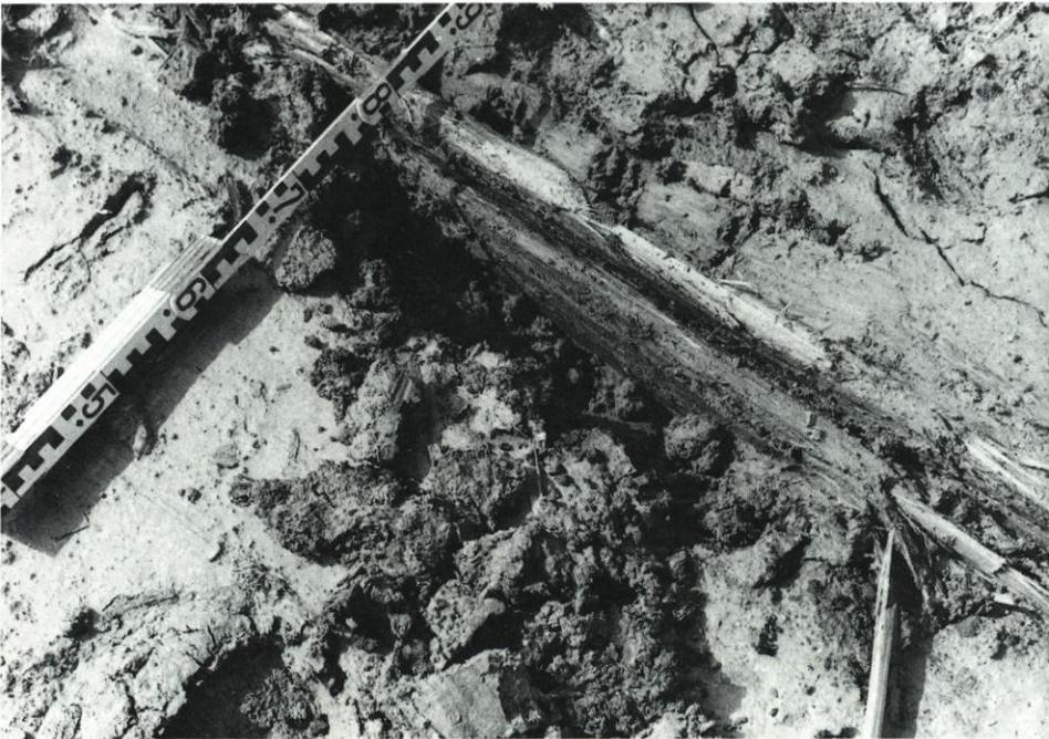
Abb. 3.6. Die unteren Stackdeichplanken waren durch die Einbettung in den fetten Ton des alten Deichkörpers vielfach noch in doppelter Schichtlage erhalten
