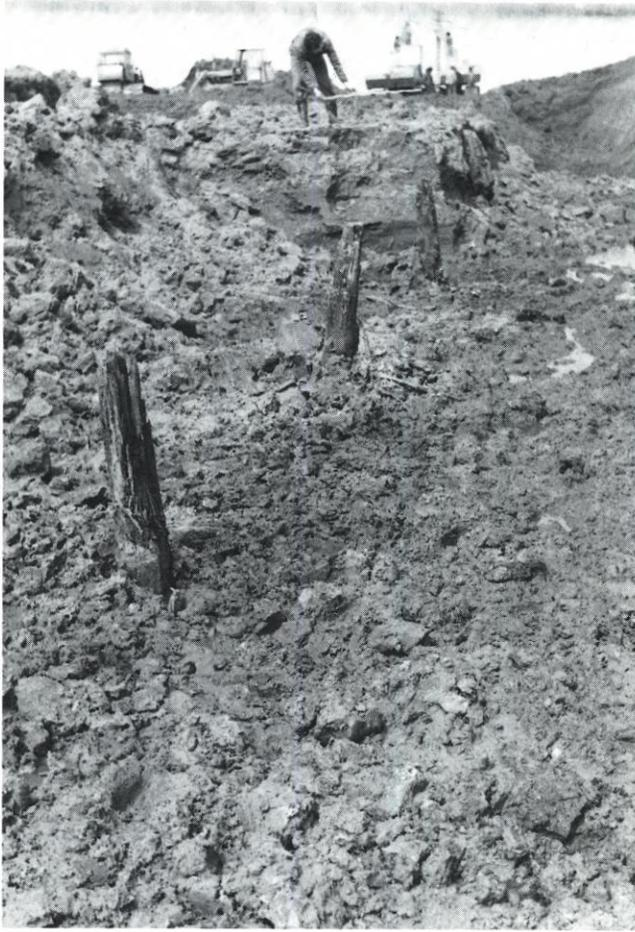
Abb. 3.2. Überblick über die Baustelle im Anfang der Entkernung. Rechts oben die „abgebagerte“ Steilwand des alten Deichkörpers und in der Bildmitte die nordwärts in Richtung Schobüll zeigenden Stammeichen des Stackdeiches
