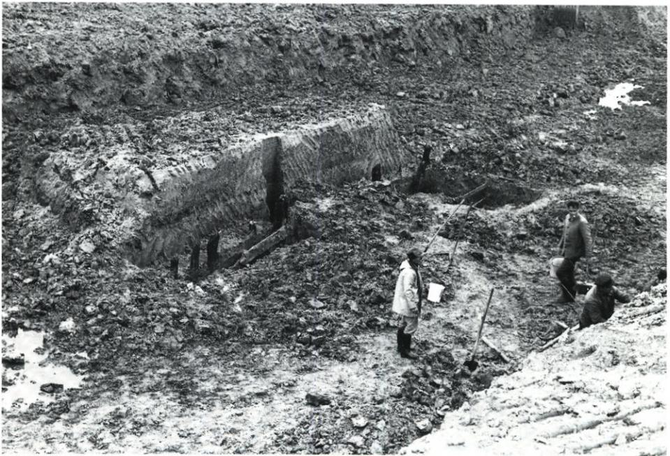
Abb. 3.2.1. Der vom Greifbagger zwecks Durchführung der deichbauhistorischen Dokumentation unberührt gebliebene „Block“ aus dem mittelalterlichen Deich. Die in der Mitte des Blocks von oben nach unten reichende Aussparung war für die Entnahme von Bodenproben geglättet worden (vgl. Abb. 3.2.2)
