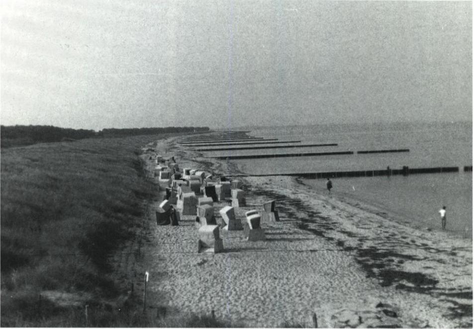
Abb. 7: Buhnensystem Neuendorf/Hiddensee mit  $BL_t$  (i. M.) = 47,4 m und BA (i. M.) = 89,3 m; Baujahr 1936 (Foto: D. WEISS; Aug. 1990)
