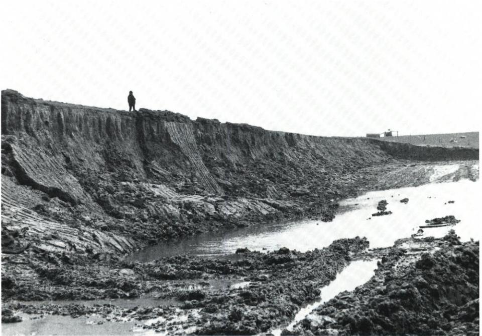
Abb. 4.1. Der vom Greifbagger landseitig stehengelassene Rest vom alten Deich kam aufgrund des hohen Tongehaltes bei den einsetzenden starken Niederschlägen ins Rutschen. Allein ortsfest blieb das schmale Band der Deichkronen-Vegetation
