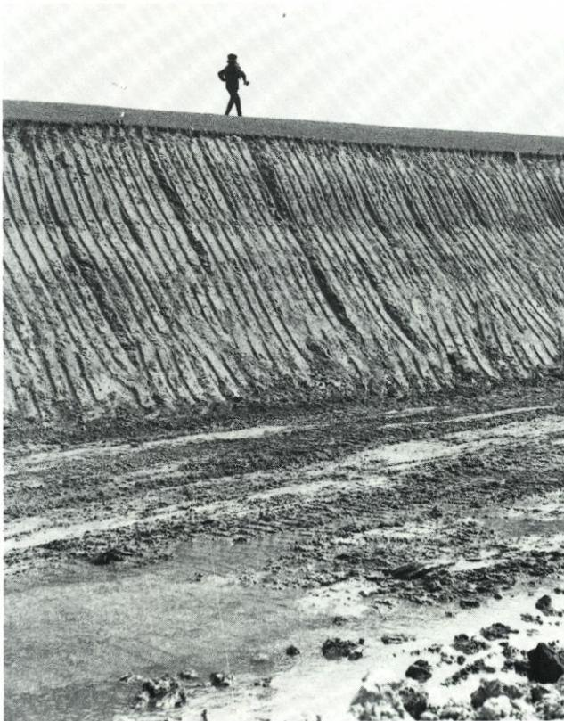
Abb. 4.2. Während der dann folgenden windreichen Trockenperiode konnte der Bagger die Wand neu profilieren. Damit war für die Durchführung der vor Ort vorzunehmenden Dokumentation die entscheidende Vorleistung geschaffen
