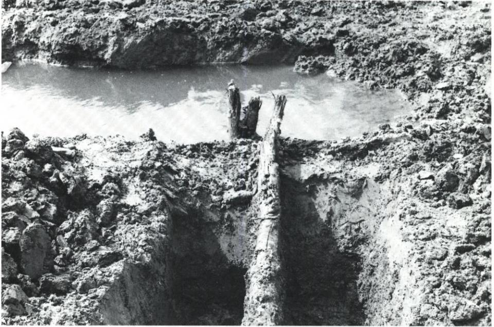
Abb. 3.7. Stammeiche und angeschäftetes Ankerholz während der Freilegung nach starken Niederschlägen mit hohem Wasserstau im tonigen Deichkörper
