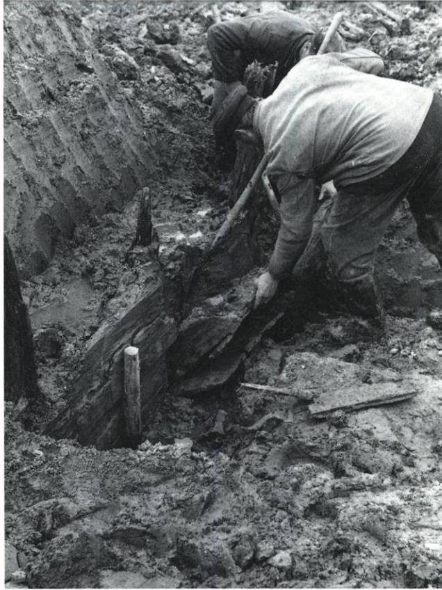
Abb. 3.4. Nur eine behutsame Grabungstechnik führte dazu, das Stackdeichgebilde funktionsgetreu zu dokumentieren. Die noch im historischen gezimmerten Verband stehenden Plankenhölzer mußten zusätzlich mit der Hand abgefangen werden
