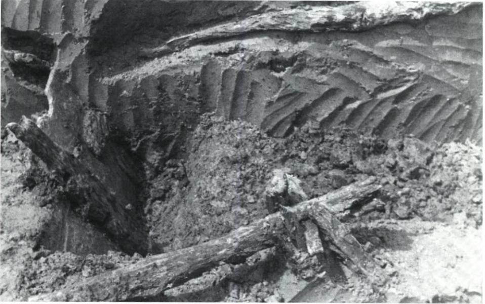
Abb. 1.5.8. Die im Jahre 1949 durchgeführte Freilegung des mittelalterlichen Stackdeiches neben dem alten bauffälligen Holzsiel des Porrenkooges
