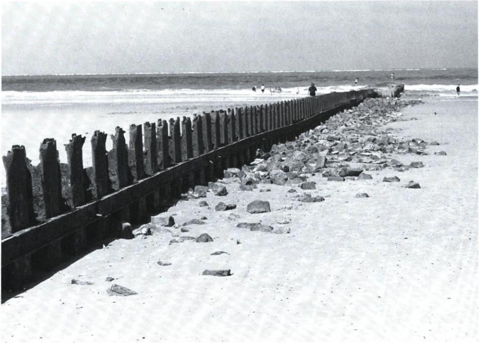
Abb. F 32. Einwandbuhne aus Stahlspundbohlen, die im oberen Bereich durch Korrosion und Sandschliff starke Schäden aufweist
