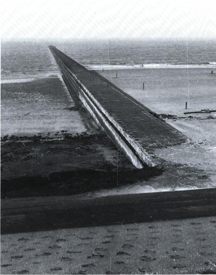
Abb. F 26. Kastenbühne aus Stahlbetonbohlen mit einer Abdeckung aus Betonplatten am Südstrand von Borkum
