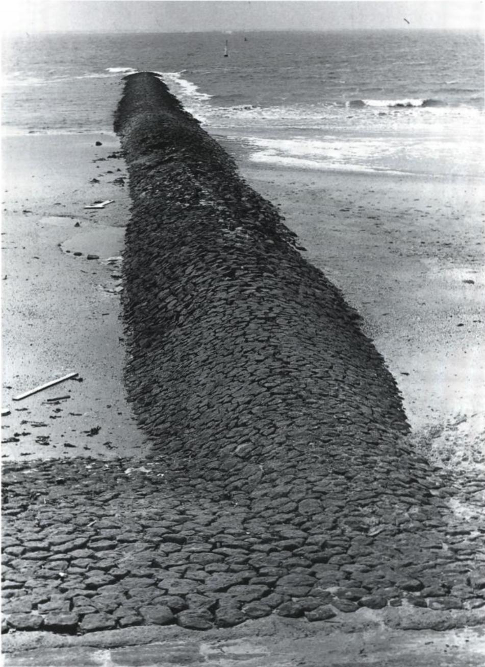
Abb. F 13. Geböschte Steinbuhne mit Abdeckung aus Basaltsäulen am Westkopf von Norderney
