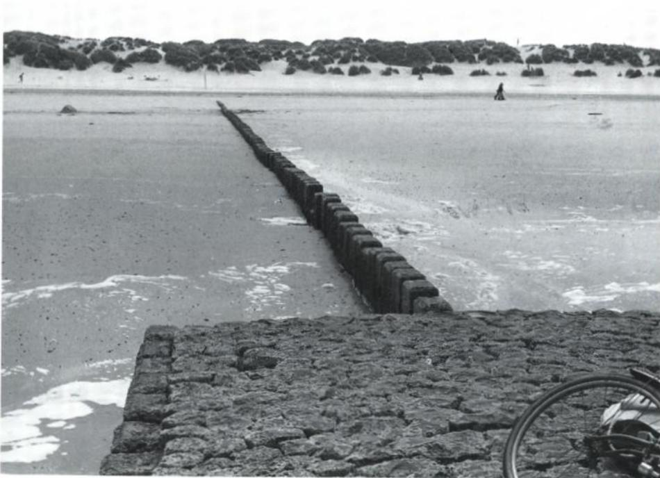
Abb. F 20. Einwandbuhne aus Stahlbetonbohlen als Verbindung zwischen Deckwerk und Kastenbuhnenkopf am Nordstrand von Norderney
