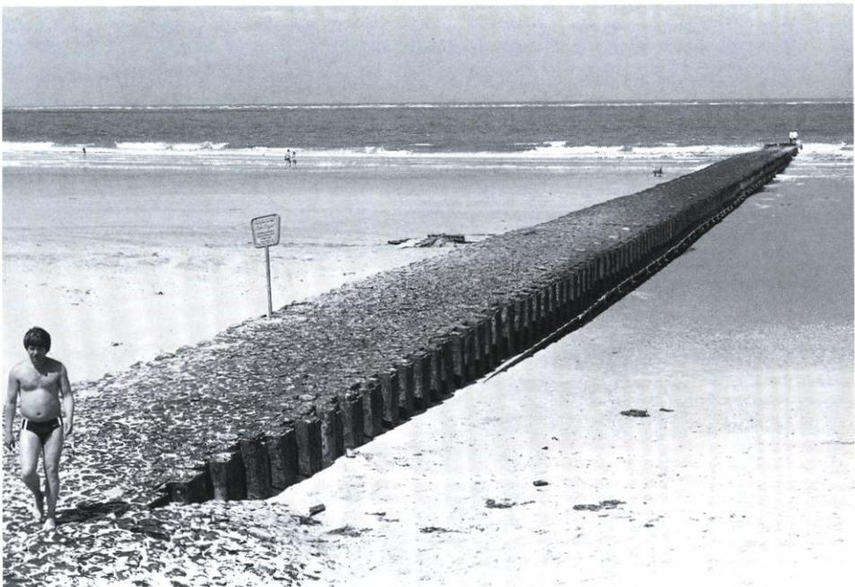
Abb. F 22. Kastenbühne aus Stahlspundbohlen mit Basaltplaster am Nordstrand von Norderney
