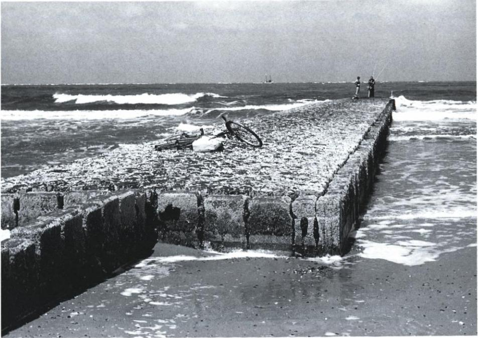
Abb. F 21. Kopf einer Einwandbühne in Form einer Kastenbühne aus Stahlbetonbohlen mit Basaltplaster am Nordstrand von Norderney
