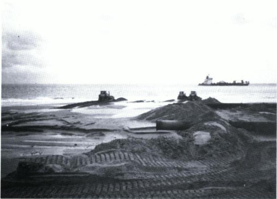
Abb. 3. Spülfeld eines Spülkörpers
