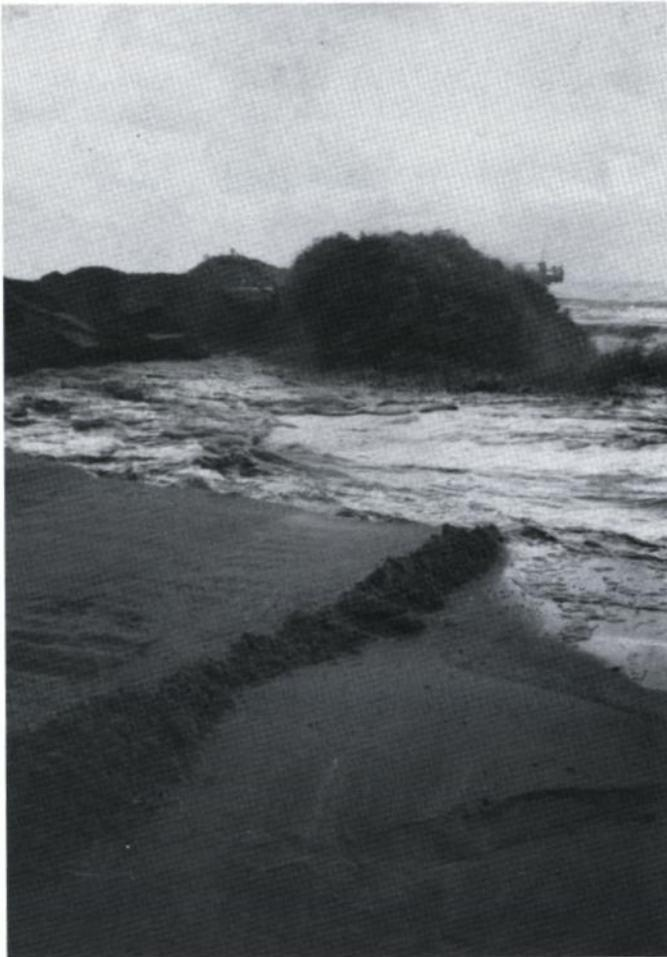
Abb. 2. Spülvorgang an einem Spülkörper
