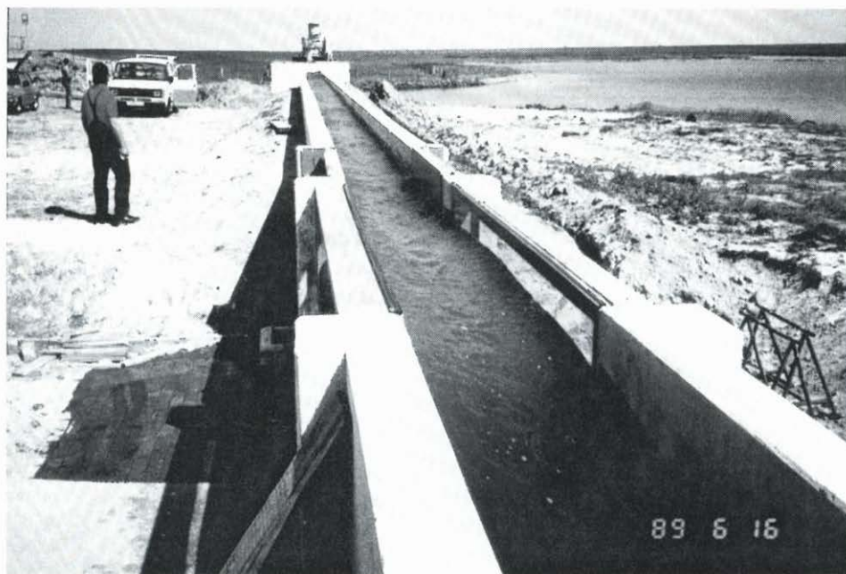
Abb. 26: Der Seewasserversuchskanal am Spülbecken für die Außentieferräumung in Neßmersiel. Im Vordergrund: Meßstrecke mit Sichtscheiben
