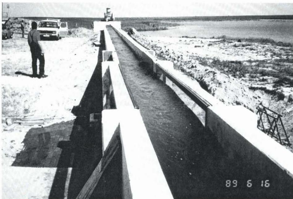
Abb. 26: Der Seewasserversuchskanal am Spülbecken für die Außentiefräumung in Neßmersiel. Im Vordergrund: Meßstrecke mit Sichtscheiben
