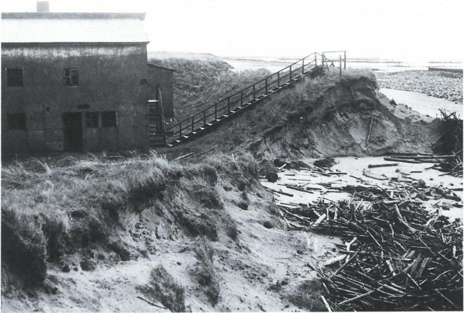
Abb. 15: Bei den Herbststurmfluten 1941 gebrochener Ringdeich und beschädigtes Schäferhaus. Im Hintergrund rechts Reste des Deckwerks und der Bühnen
