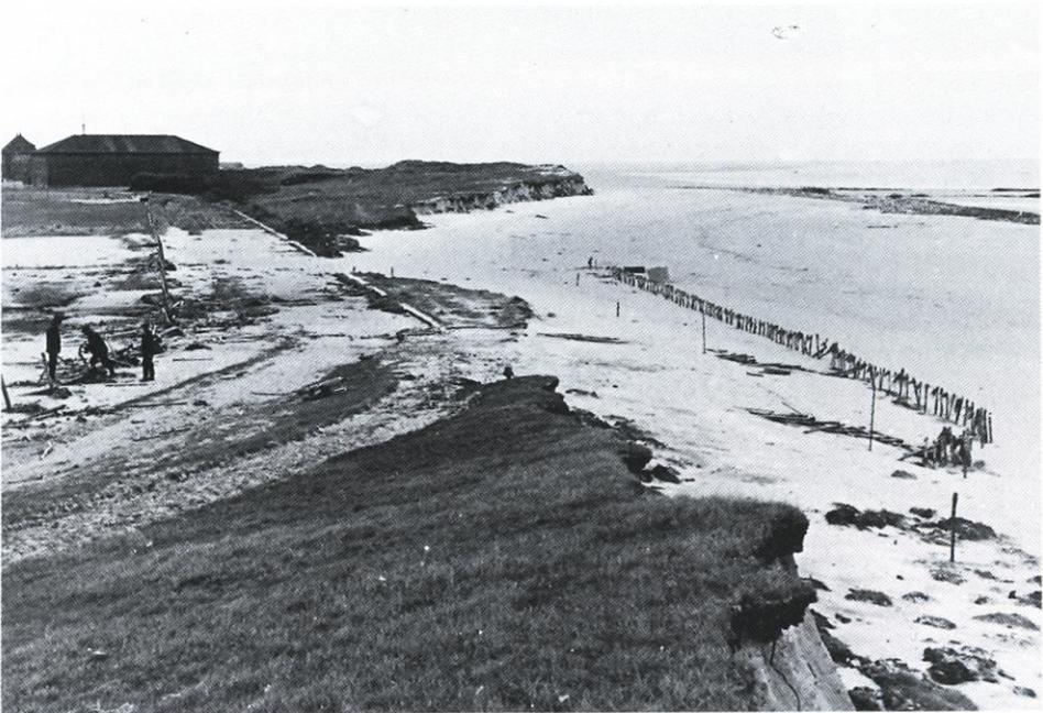
Abb. 16: Sturmfluteinbruchsenke südlich des Ringdeiches. Im Vordergrund südlicher Ringdeichrest, im Hintergrund der Luisenhof, rechts außen Deckwerksreste bereits in der Tidezone (Aufnahme November 1942)
