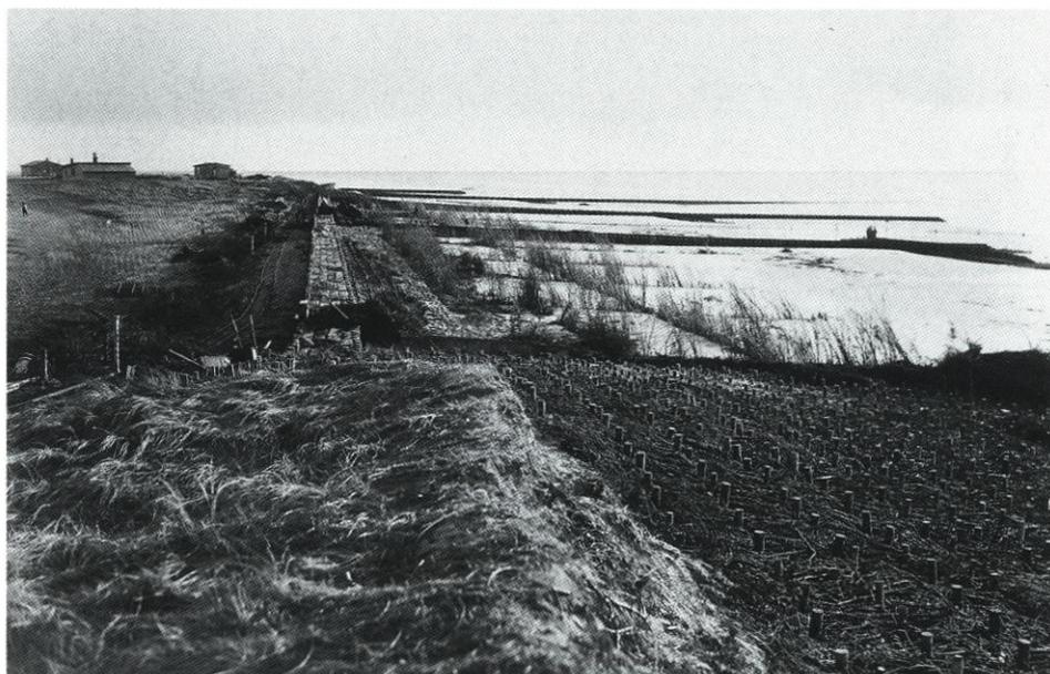
Abb. 11: Verbau einer Dünenlücke durch einen Faschinendamm mit Steinbeschwerung 1930. Im Vordergrund Mitte der Ringdeich, rechts Stahlspundwandbuhnen im Bau
