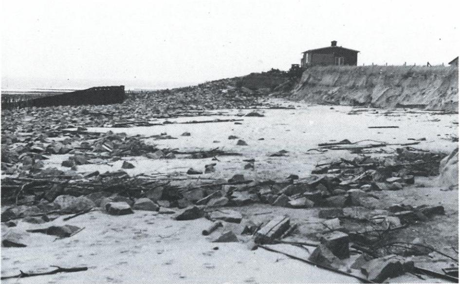
Abb. 14: Sturmflutschäden 1936: Zerstörtes Deckwerk und Dünenabbrüche bis an die Arbeiterbaracke und Schmiede und den Ringdeich, ganz rechts Schäferhaus
