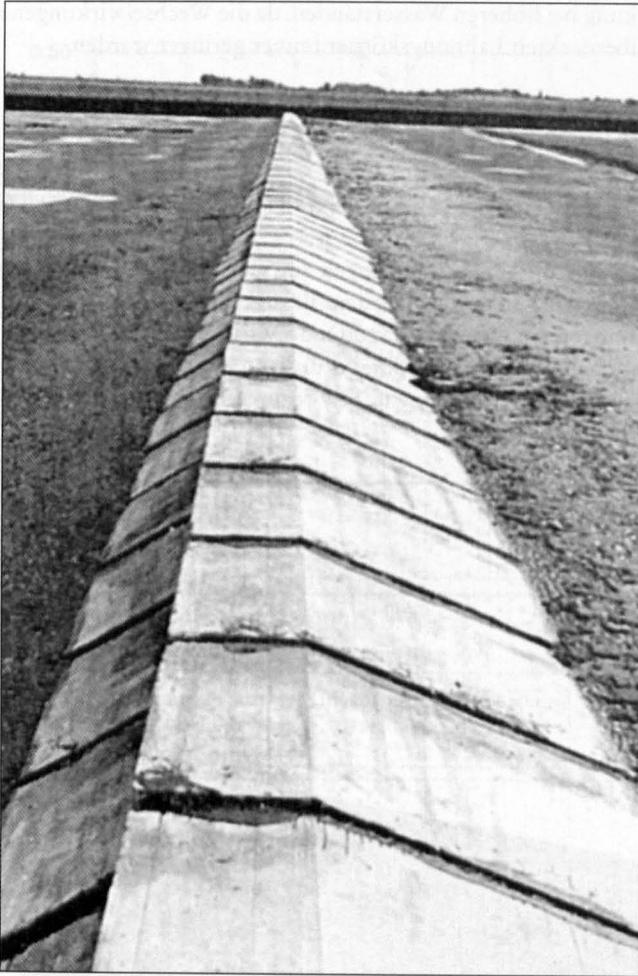
Abb. 8: Lahnung aus Betonfertigteilen an der ostfriesischen Küste (ERCHINGER, 1970)
