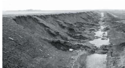
Stark beschädigte Deichstrecke des Grothusenkooges in Dithmarschen, Sturmflut 1976. Durch überschwapende Wellen ist die zu steile Innenböschung zerstört. (Petersen und Rohde, 1991)
