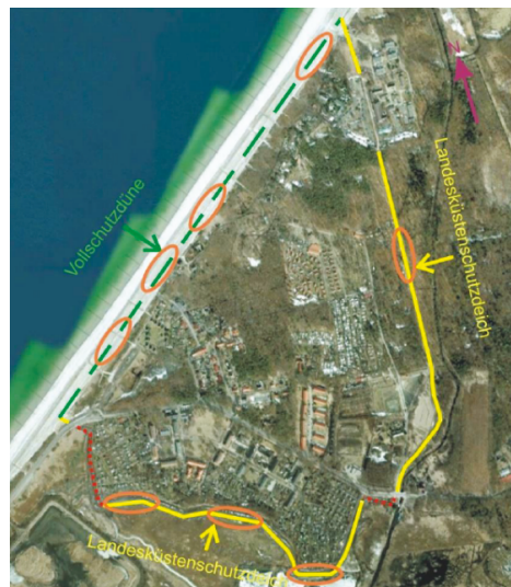
Abbildung 17: Versagenslokalationen entlang der Hochwasserschutzanlagen.
