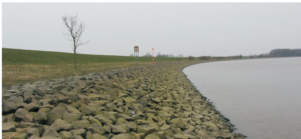
Abbildung 1: Deckwerke am Emsufer als Schutzschicht gegen Erosion der Uferböschung infolge hydraulischer Belastungen.
