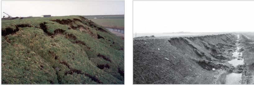
Abbildung 7: Hangparalleles Gleiten.
