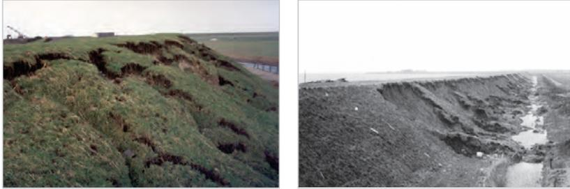
Abbildung 7: Hangparalleles Gleiten.
