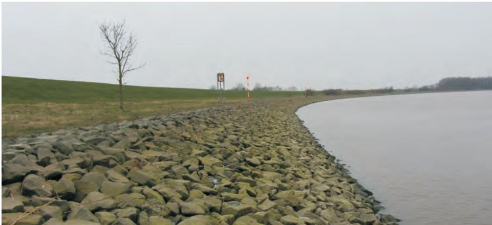
Abbildung 1: Deckwerke am Emsufer als Schutzschicht gegen Erosion der Uferböschung infolge hydraulischer Belastungen.
