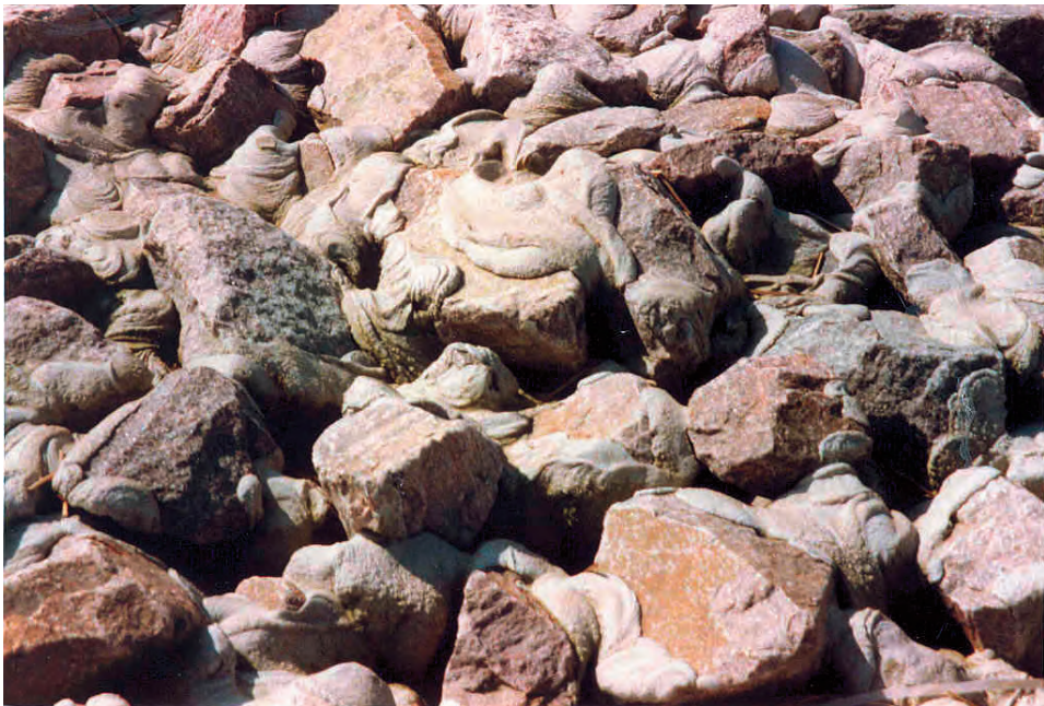
Abb. C 1: Verklammertes Deckwerk (Colcrete-Verfahren)
