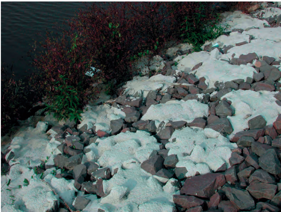
Abb. C 2: Verblockung: Deckwerk mit vergussarmen Zonen (Verblockungssystem Möbius)
