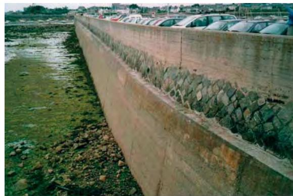
b. Sanierung mit Ortbetonwand
