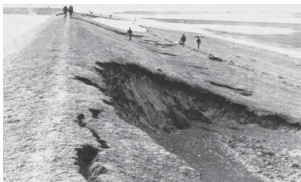
a. Kraterförmige Schäden an einem Deich
