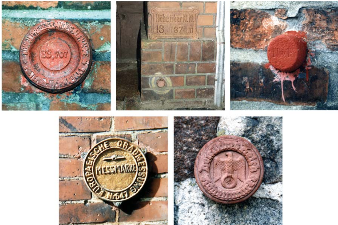
Abb. 5: Beispiele für erhaltene Vermarkungen von Nivellements Punkten früherer Höhennetze. Höhenmarke (oben links) und Mauerbolzen (oben Mitte und rechts) der Trigonometrischen Abteilung der Königlich Preussischen Landesaufnahme, Höhenmarken des Geodätischen Instituts Potsdam (unten links) und des Reichsamtes für Landesaufnahme (unten rechts)
