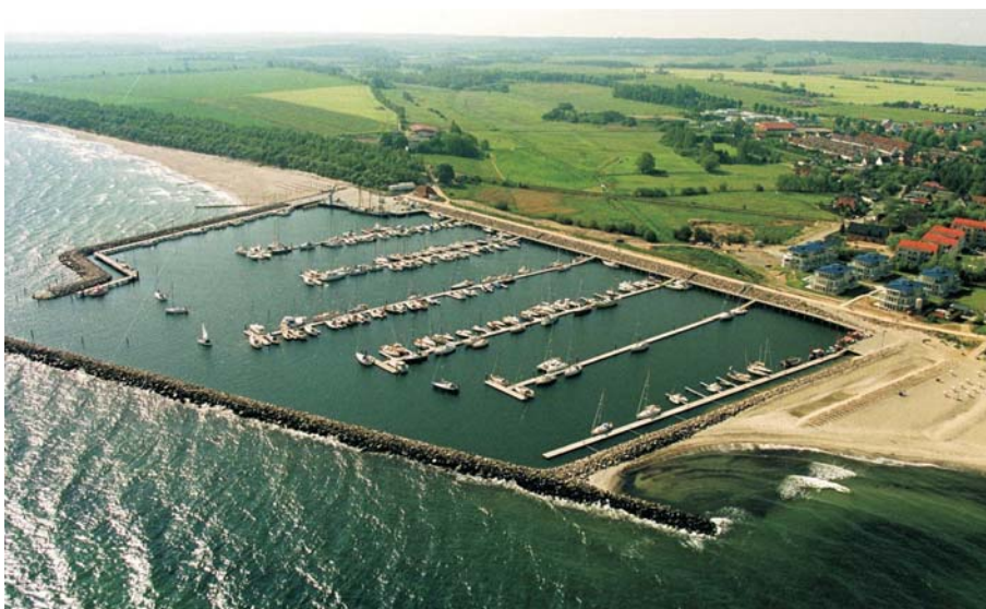
Abb. 2: Situation 2003, Sportboothafen Kühlungsborn (KLONOWSKI, Ostseezeitung)
