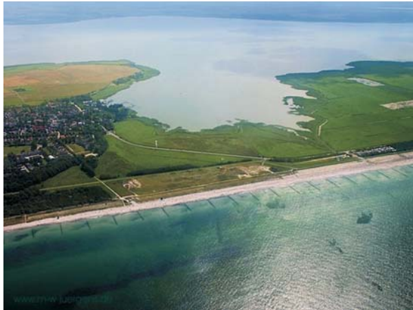
12a) Luftbild des Fischlands an der Durchstichstelle
