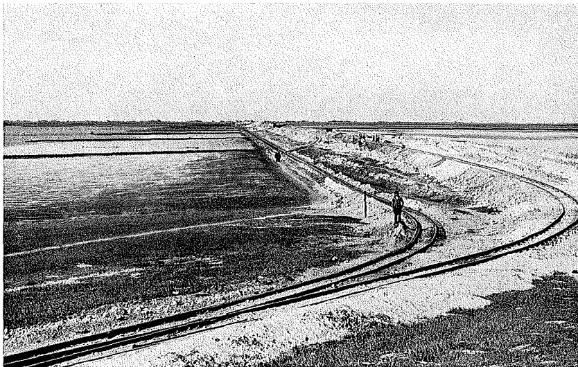
Abb. 20. Bodenschüttung beim Damm Festland Nordstrand Aufn. Hinrichsen
