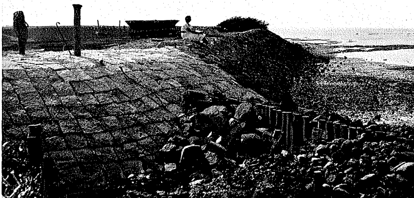
Abb. 29. Steindecke auf Hallig Nord- marsch-Langeneß Aufn. Thiel
