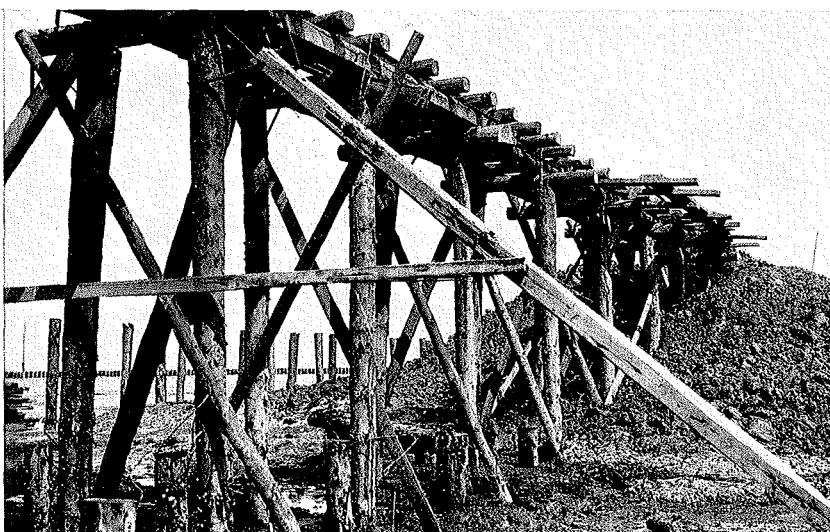
Abb. 10. Schüttbrücke für eine Priel- durchdämmung bei der Finkhaushallig Aufn. Baumann
