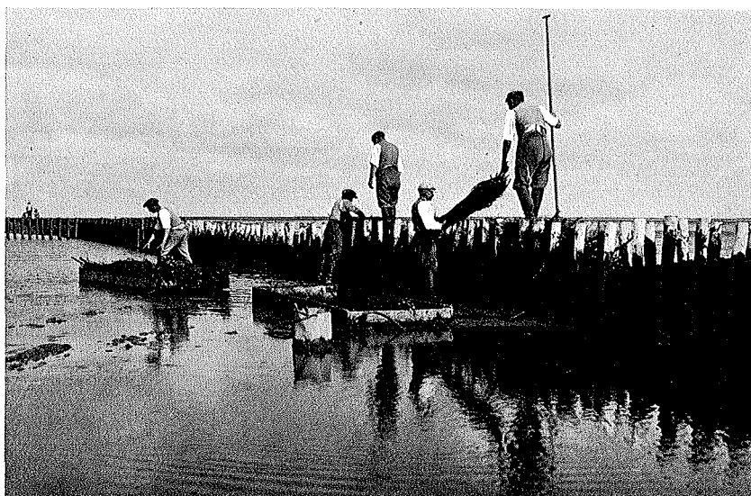
Abb. 3. Bau einer Buschlahnung Aufn. Odefey
