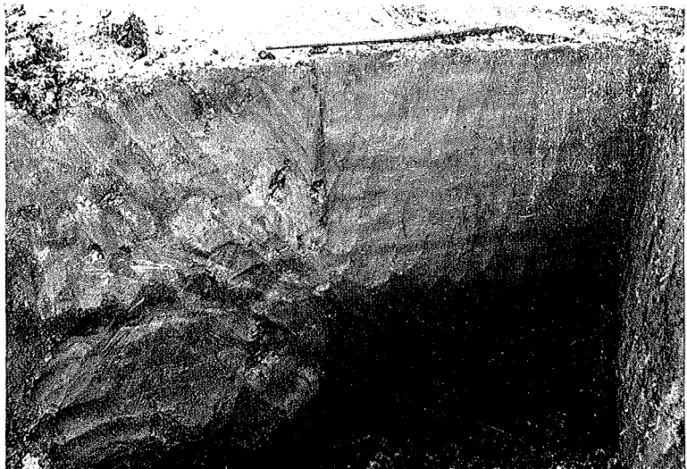
Abb. 21 Schnitt durch den Rand eines Abbaufeldes nördlich der Hallig Habel. Links die mit Abraum gefüllten Entnahmestellen, rechts die anstehenden Sedimente Darg, darunter Torf. Bildarchiv Westküste 22. VI. 38 Aufn. Bantelmann
