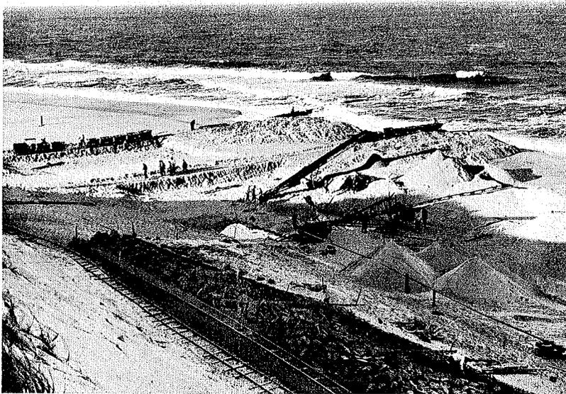
Abb. 14. Blick von der Randdüne auf die Deckwerksbaugrube.
