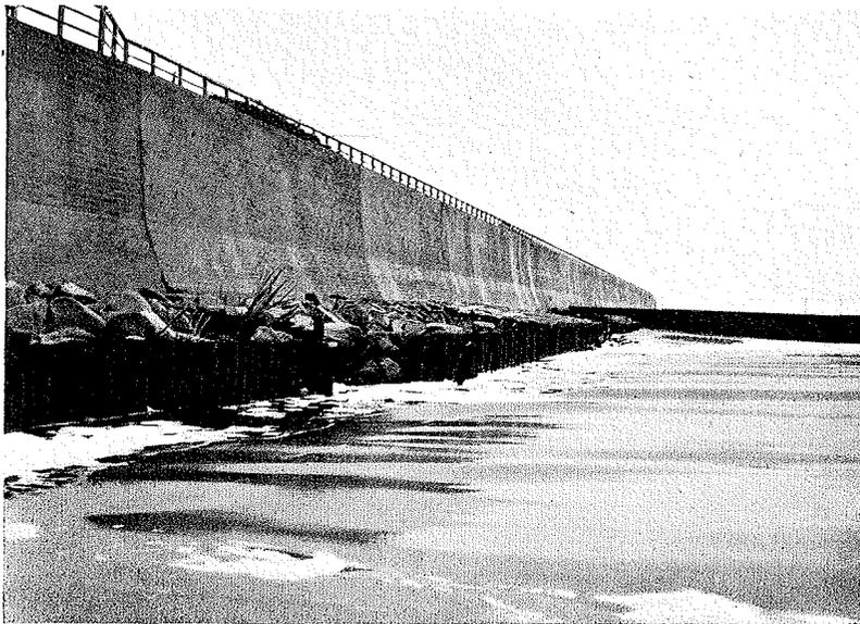
Abb. 11. Bei Sturmflut erfolgte Vertiefung des Strandes vor der Fußsicherung der Westerländer Strandmauer.
