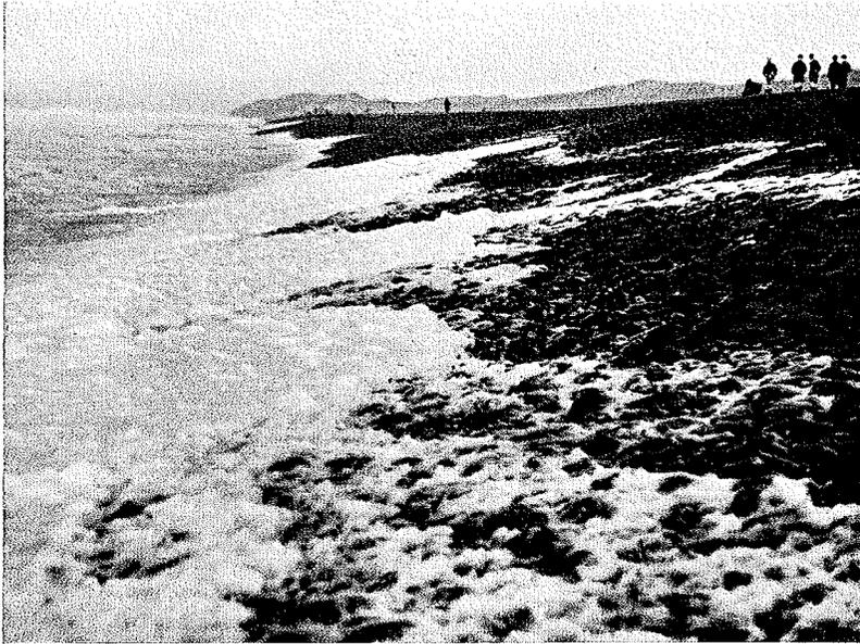
Abb. 15. Auslaufen von Brandungswellen auf der Deckwerksböschung.
