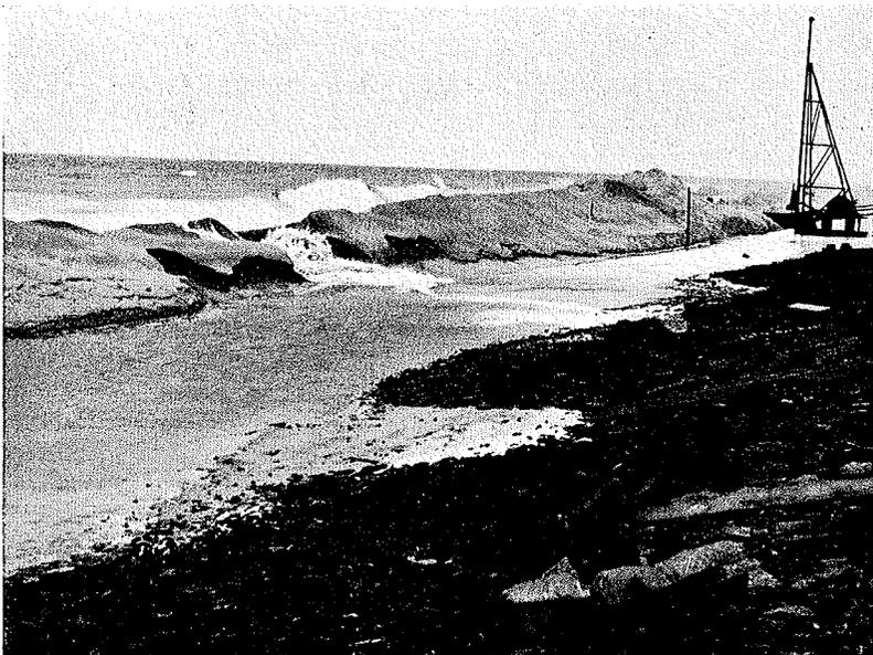
Abb. 16. Sturmflut bricht in die Baugrube ein.
