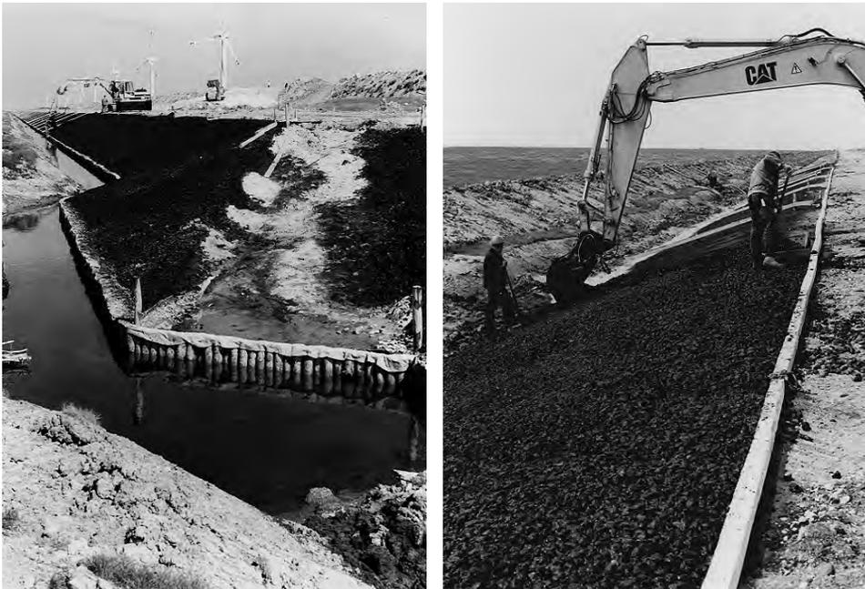
Abb. G 50b+c: Deichverstärkung Friedrich-Wilhelm-Lübke-Koog hinter Vorland 2001/2002: Einbau von Mastixschotter als Fußdeckwerk auf Bitumensand-Filter bis zur Überschlagssicherung
