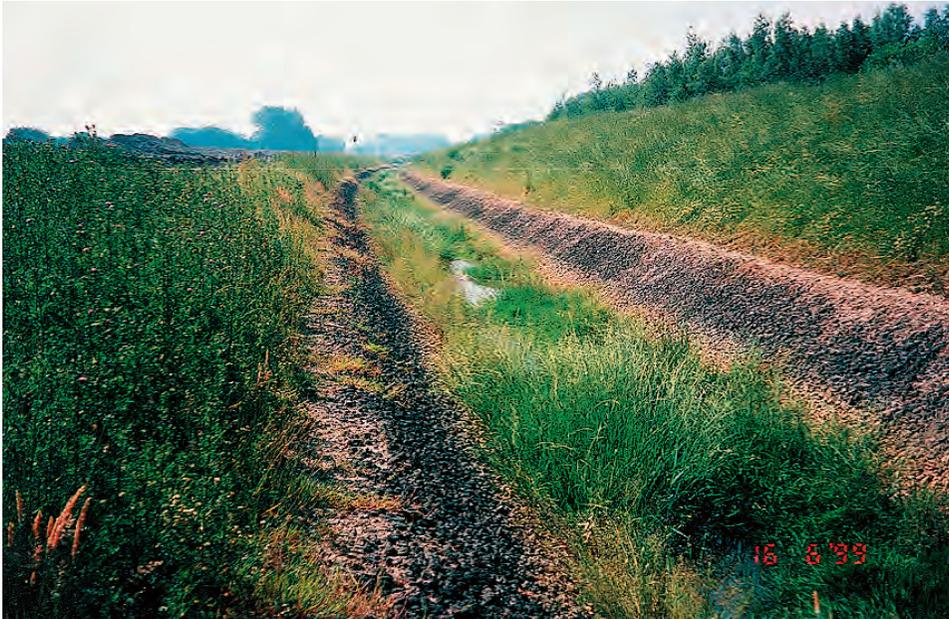
Abb. G 55b: Deich im Tidebereich des Elbe-Ästuars mit höherem Vorland bei Glückstadt, wasserseitiger Entwässerungsgraben zur schnelleren Wasserabführung: Begrüntes offenes Deckwerk aus Mastixgestein
