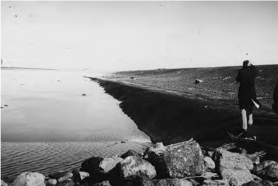
Abb. G 54: Unbewehrte dichte Asphaltmastixmatten-Vorlage als Schutz gegen Unterspülung
