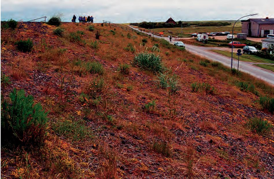
Abb. G 51c: Deichverstärkung Tümlauer Koog 1994/95 (Westabschnitt), Stat. 2+660 bis Stat. 2+860: Deckwerk aus 20 cm Mastixschotter auf der Außenböschung bis zur Dammkrone und 15 cm bis zum Fuß der Binnenböschung über das gesamte Deichprofil – wasserdurchlässig und begrünt
