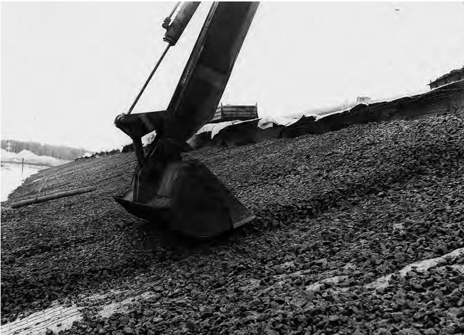
Abb. G 53: Verlegen von Mastixgestein mit dem Hydraulikbagger, leichtes Andrücken mit der
