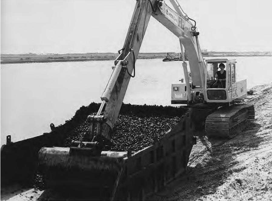
Abb. G 52: Container zur Zwischenlagerung von Mastixgestein an der Einbaustelle
