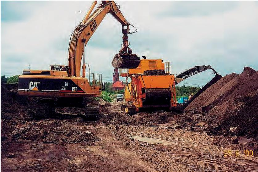
Abb. G 48g: Bodenverbesserung durch Aufbereitungsgeräte
