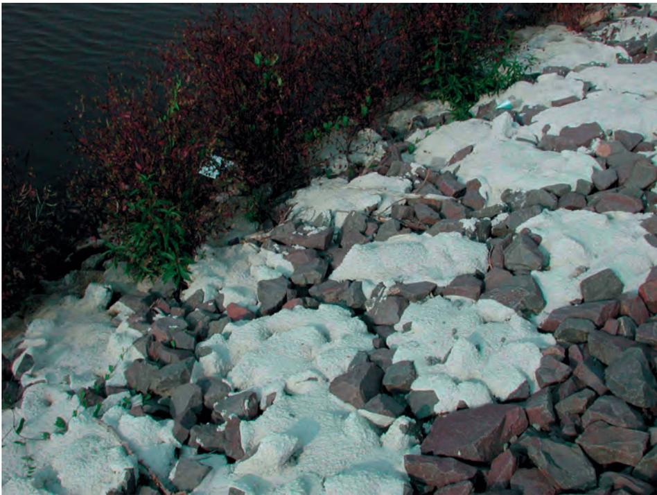
Abb. C 2: Verblockung: Deckwerk mit vergussarmen Zonen (Verblockungssystem Möbius)
