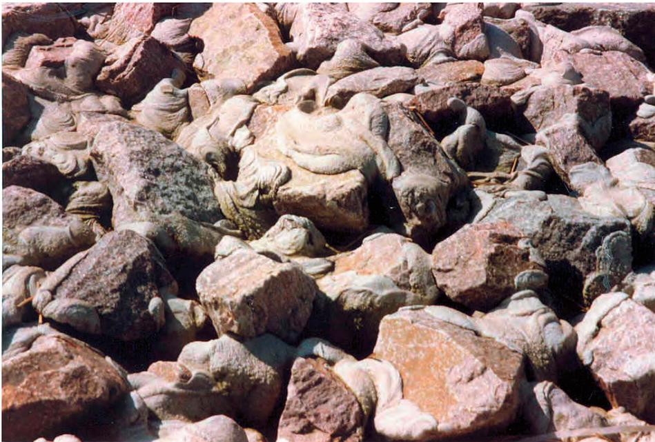
Abb. C 1: Verklammertes Deckwerk (Colcrete-Verfahren)
