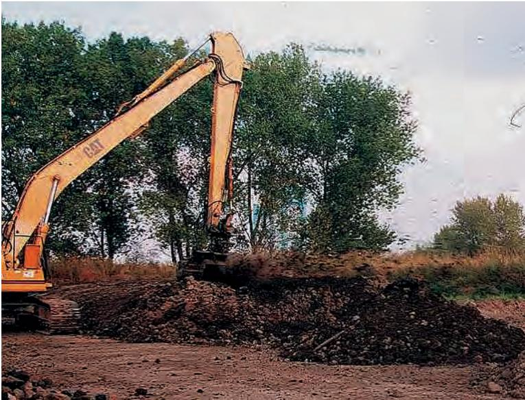
Abb. G 48f: Bodenverbesserung durch Fräsen
