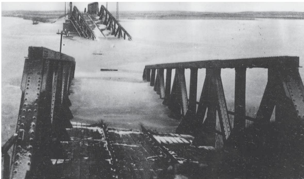
Abb. 3.1: Durch die Sturmflut am 30./31.12.1913 zerstörte Eisenbahnbrücke (Klör-Brücke) zwischen Bresewitz und Pruchten in Vorpommern (Darß-Zingster Boddengewässer). Foto: Archiv HUPFER
