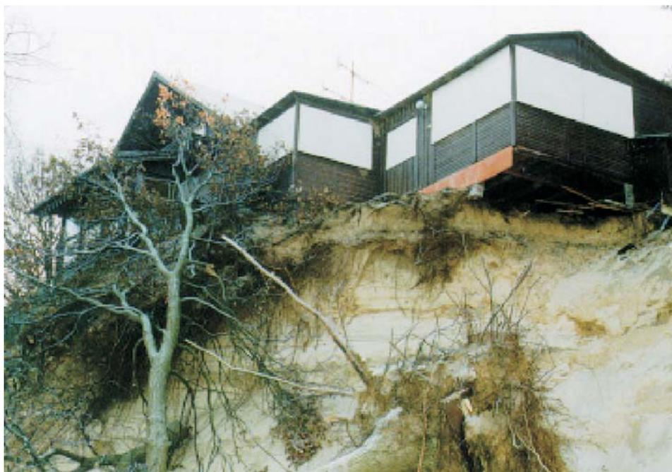
Abb. 3.5: Vom Abstürzen bedrohtes Gebäude an einem abgebrochenen Kliff.
