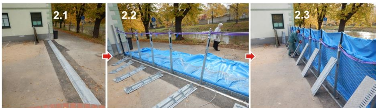
Abbildung 2: 2.1 eingebauter Zustand | 2.2 Aufbau des Schutzsystems | 2.3 die 11 m lange Schutzwand ist in 10 Minuten aufgebaut.
