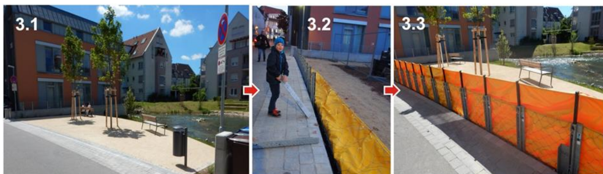
Abbildung 3: 3.1 eingebauter Zustand | 3.2 Aufbau (von Jedermann) | 3.3 die 20 m lange Schutzwand ist in 15 Minuten aufgebaut.
