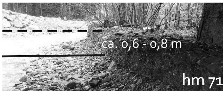
Abbildung 8: Dokumentierte Geschiebeablagerungen im hm 71
