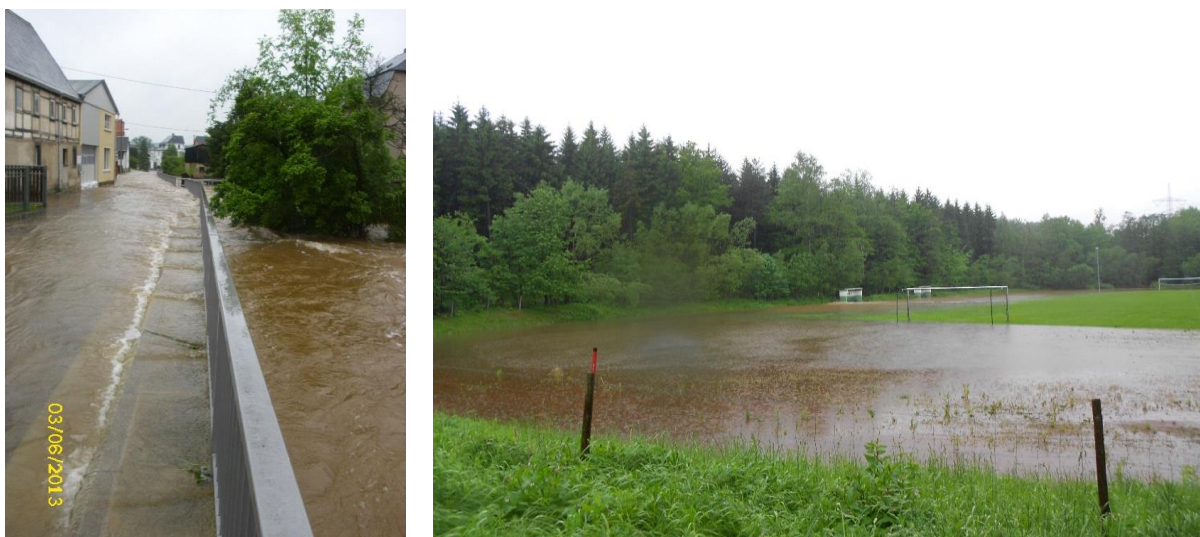
Abbildung 6: Hochwasser in der Ortslage Oelsa (links) und Überflutungsbeginn am Waldstadion (rechts) am 03.06.2013
