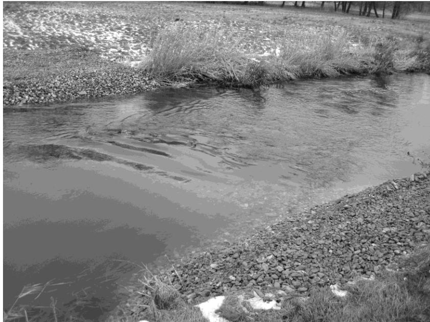
**Abbildung 4:** Beispiel für eine Lenkbuhne
