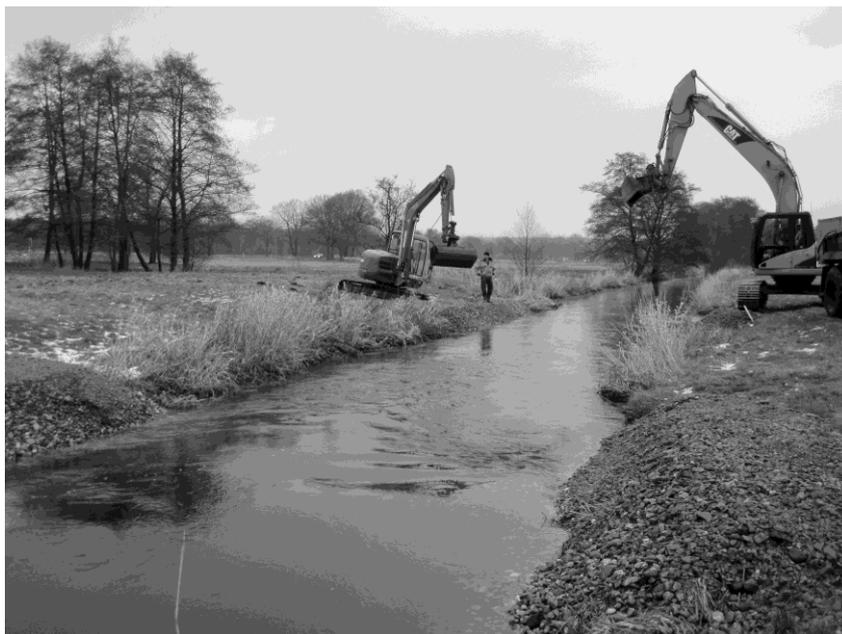
**Abbildung 3:** Seeve Wiedenhof, Lenkbuhnen- und Laichbettaufbau erfolgt mit Großgerät
