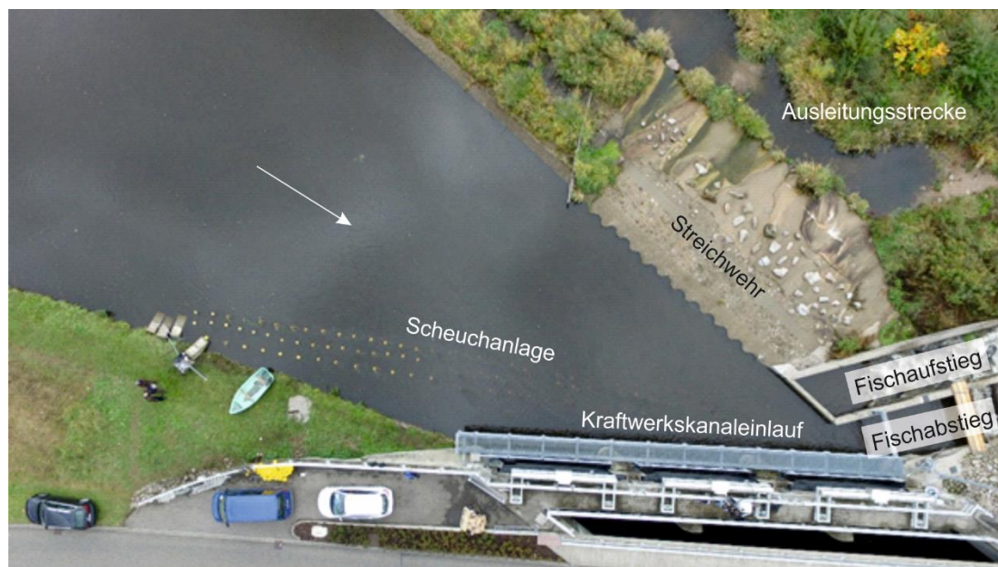
Abbildung 5: Luftbild der drei Elektrodenreihen der Scheuchanlage am Kraftwerkskanaleinlauf Rotenfels (Quelle: EnBW)
