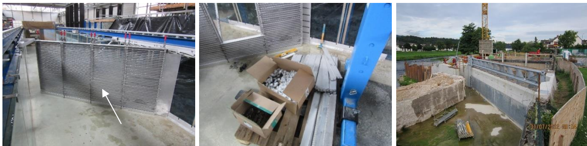
Abbildung 2: Schrägwehre in der Laborrinne mit s = 18 mm Stabweite und \delta = 45^\circ Anströmwinkel (links); während des Umbaus mit verschiedenen Abstandshaltern für die anderen Stabweiten s (Mitte); mit s = 18 mm Stabweite an der Feldanlage am Standort Ottenau/Murg während des Einbaus (rechts). (Quelle: EnBW)
