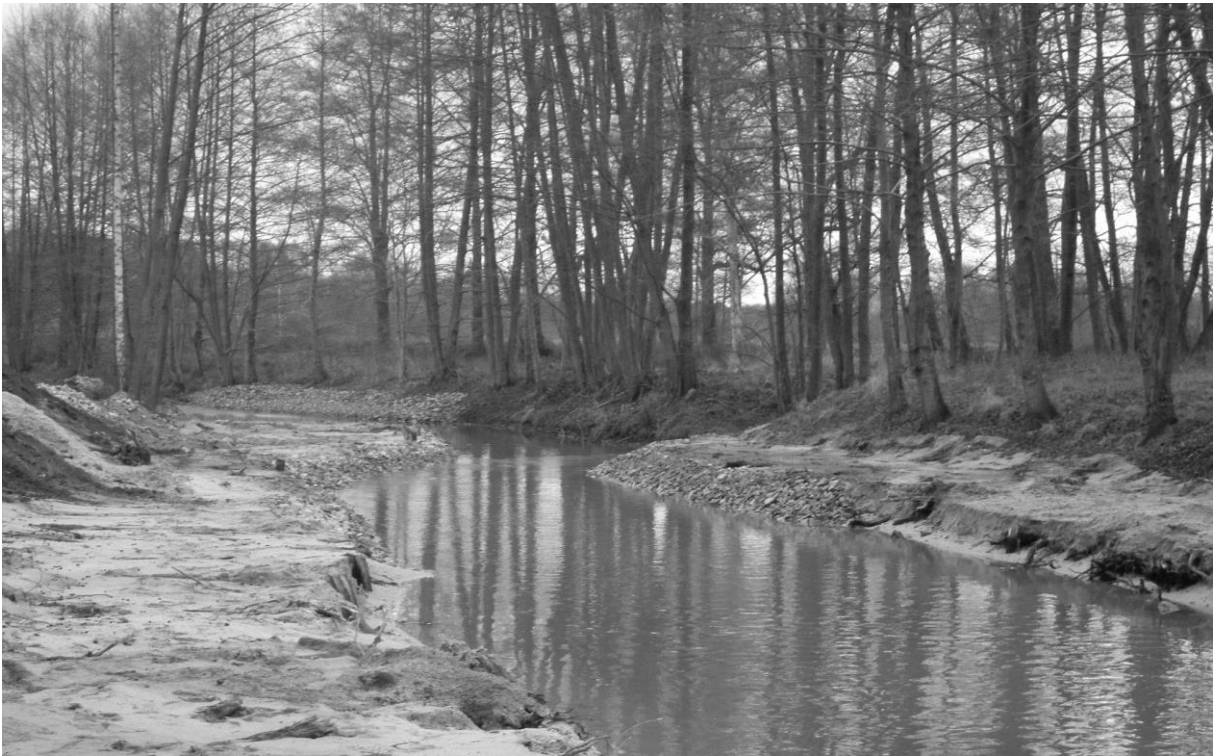
Abbildung 1: Einbau von Buhnen im Bereich der Einmündung des Altlaufs in den Neulauf – der Einlauf liegt in einer strömungsgünstigen Prallhanglage
