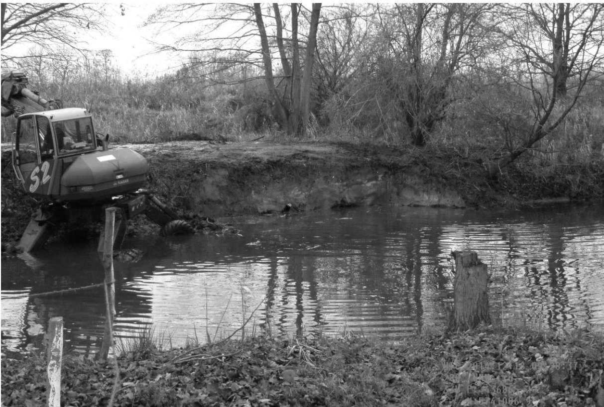
Abbildung 2: Herstellung der Ufersteilwände als mögliche Eisvogelhabitate
