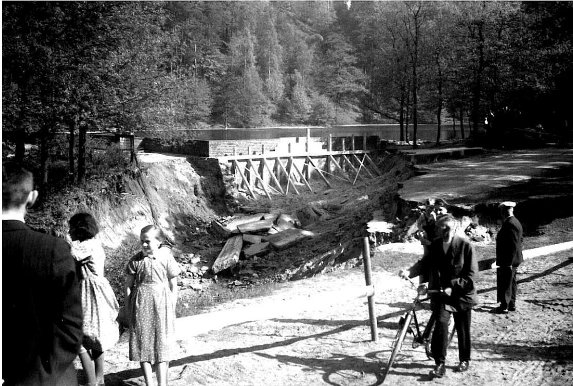
Abbildung 1: Instandsetzung des Absperrbauwerkes des Spitzgrundteiches nach dem Hochwasser vom Mai 1941 (Foto: Stadt Coswig)
