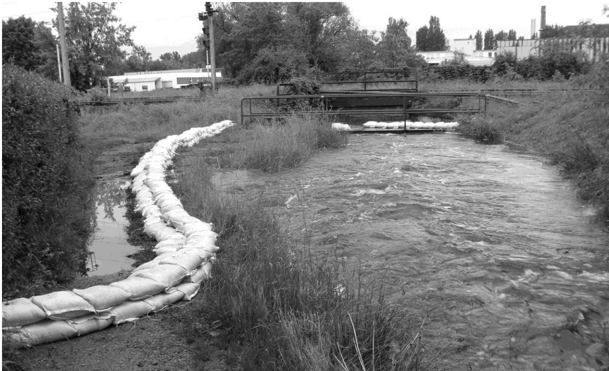
Abbildung 2: Mobile Schutzmaßnahme im Juni 2013 oh. der Bahnbrücke Dresden – Leipzig (Foto: Stadt Coswig)
