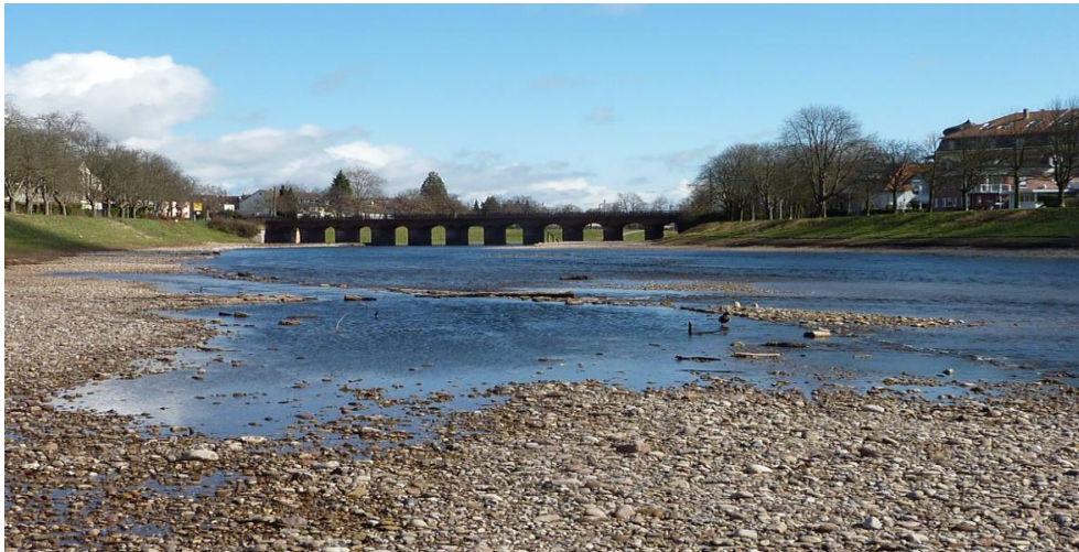
Abbildung 4: Nach dem Hochwasser
