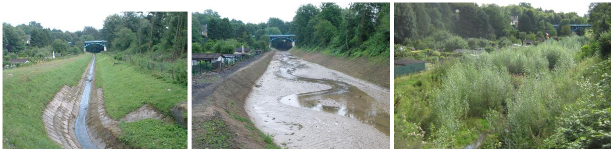
Abbildung 3: Umgestaltung des Borbecker Mühlenbachs, Links: technisch ausgebaut, Mitte: nach Umgestaltung, Rechts: 2 Jahre nach Umgestaltung
