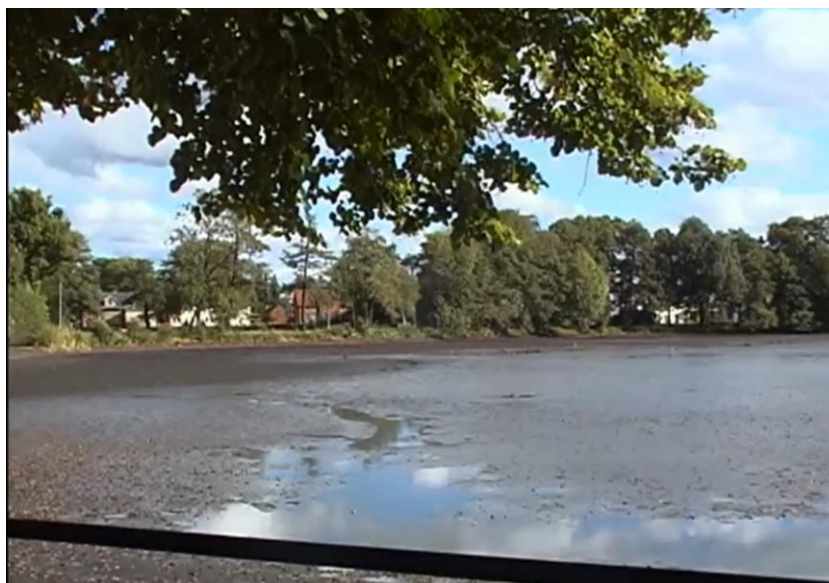
Abbildung 1: Zustand Schmelzteich Bernsdorf vor der Sanierung 2012
