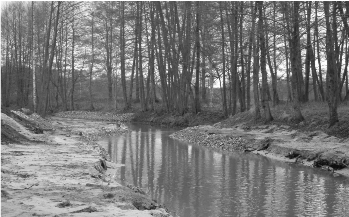
Abbildung 1: Einbau von Buhnen im Bereich der Einmündung des Altlaufs in den Neulauf – der Einlauf liegt in einer strömungsgünstigen Prallhanglage
