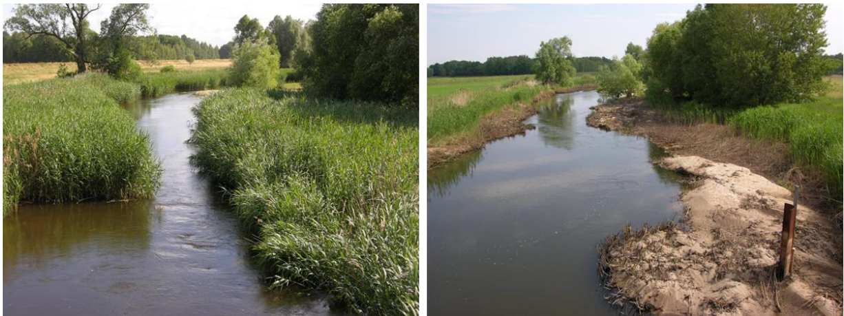
Abbildung 6: HW als „catastrophic event“: Erosion eines Schilfgürtels durch das Spree-HW (2010)
