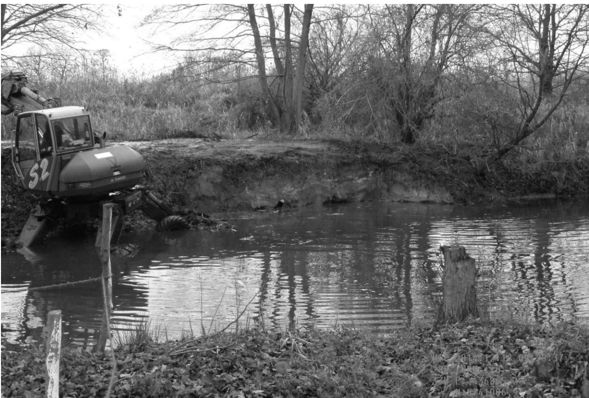
Abbildung 2: Herstellung der Ufersteilwände als mögliche Eisvogelhabitate
