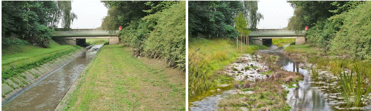
Abbildung 2: Beispiel eines Querprofils aus Abbildung 1, Links: technisch ausgebaut, Rechts: ökologisch verbessert mit Bewuchs nach einem Jahr nach Umbau
