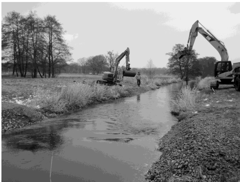
Abbildung 3: Seeve Wiedenhof, Lenkbuhnen- und Laichbettaufbau erfolgt mit Großgerät
