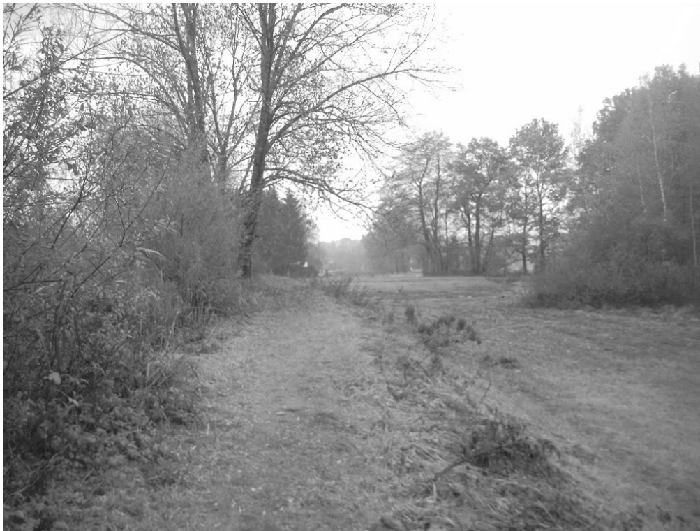
Abbildung 1: Ansicht des Dammkörpers. Stauraumseite links mit Baum- und Strauchbestand. Ab Dammfuß auf der rechten Seite beginnt der Biotopbereich.
