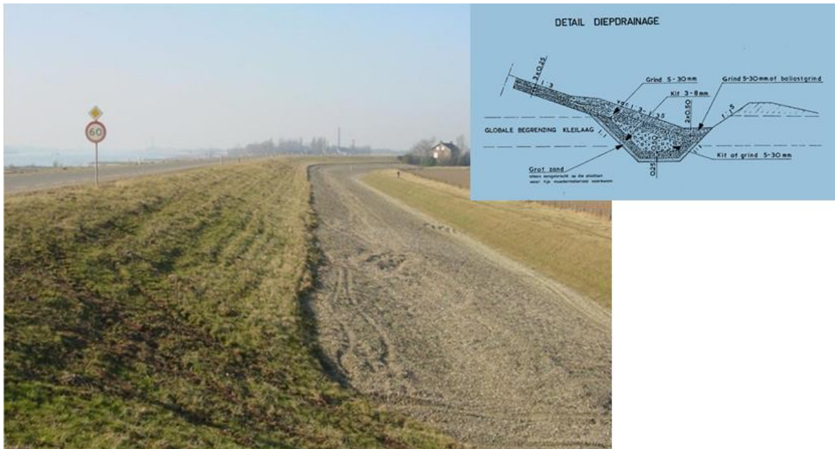
Abbildung 2: Kiesdrainage am Rhein bei Spijk (NL)
