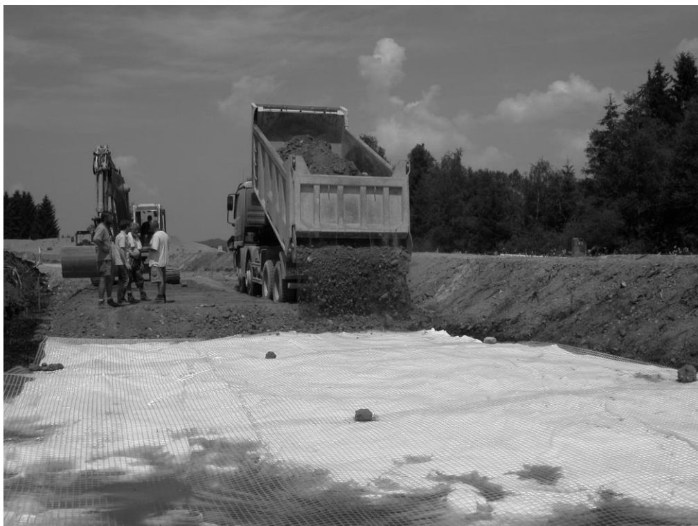
Abbildung 7: Einbau der ersten Schüttlage auf vliesunterlegtem Geogitter
