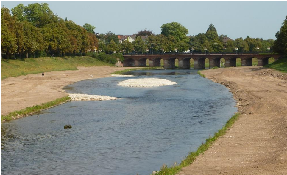
Abbildung 1: Vorlandabtrag mit Strukturverbesserung
