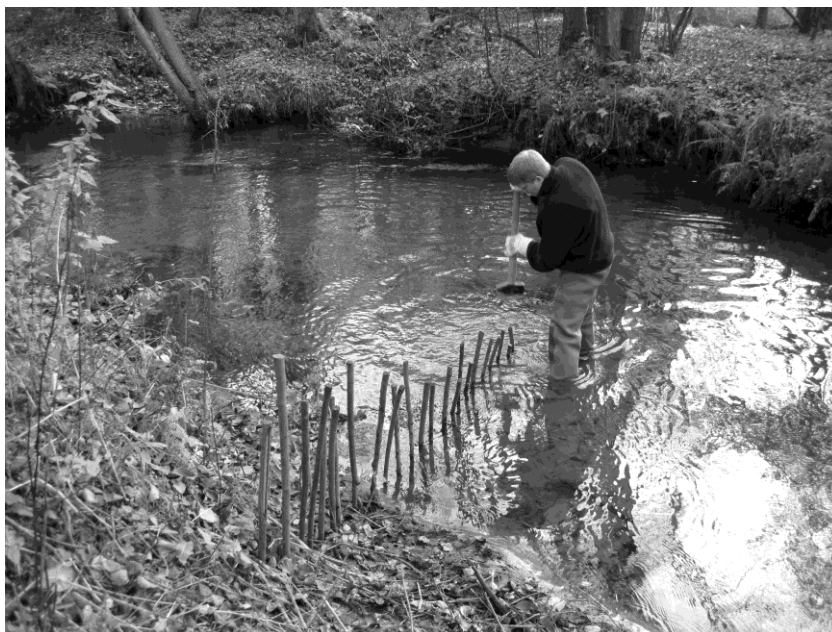
Abbildung 7: Bild 17: Rückgewinnen eines Gleithangs an der Este, Vorbereitung
