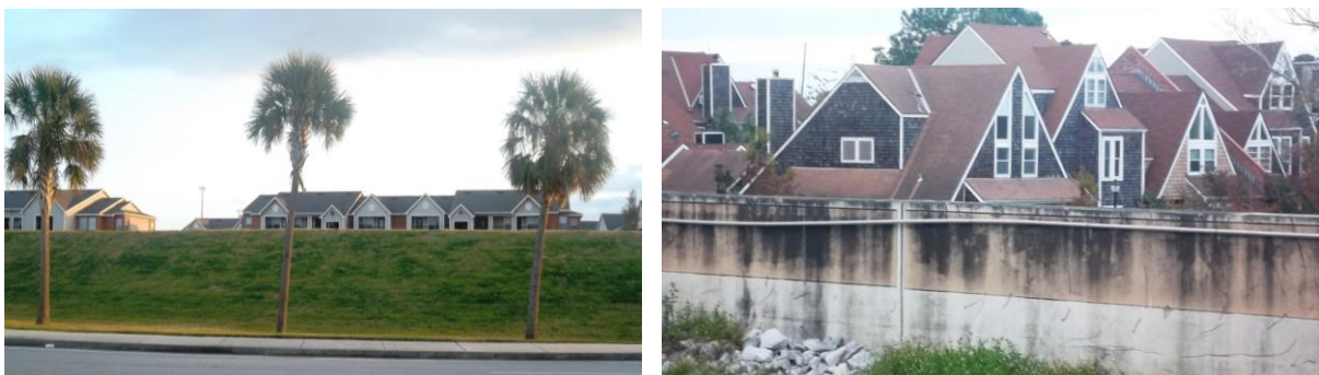
Abbildung 1: Hochwasserschutzanlagen im Norden von New Orleans am Pontchartrain-See. Links: Deich an der Uferstraße, rechts Hochwasserschutzwand am Entlastungskanal der 17. Straße. Das Erdgeschoss der Häuser und Teile des Obergeschosses werden durch die Hochwasserschutzanlagen verdeckt. (Fotos: Verfasser).
