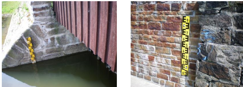
Abbildung 3 Falsche Pegelbefestigungen nach umströmten Kanten oder hinter Vorsprüngen
