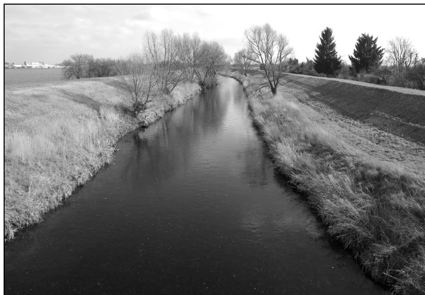
Abbildung 2: Beidseitig eingedeichte und begradigte Gera
