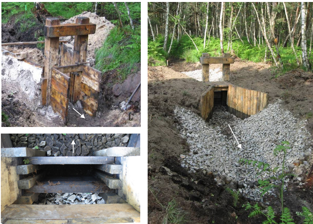
Abbildung 5: Wehr 3 in der Bauphase im Sommer 2010 mit Lehm-Tondichtungen, dem Schacht für die Holzbohlen und der Schotter-Schüttung im Zu- und Ablauf
