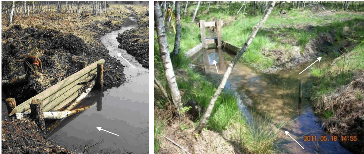
Abbildung 4: Alter Stau 17 (rückgebaut) und neues Wehr 3 (weiße Pfeile für die Fließrichtung des Wassers im Graben)
