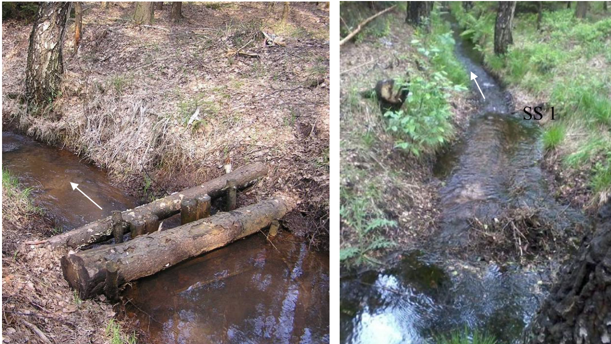
Abbildung 7: Alter Stau 1 (rückgebaut) und neue Stützschwelle 1
