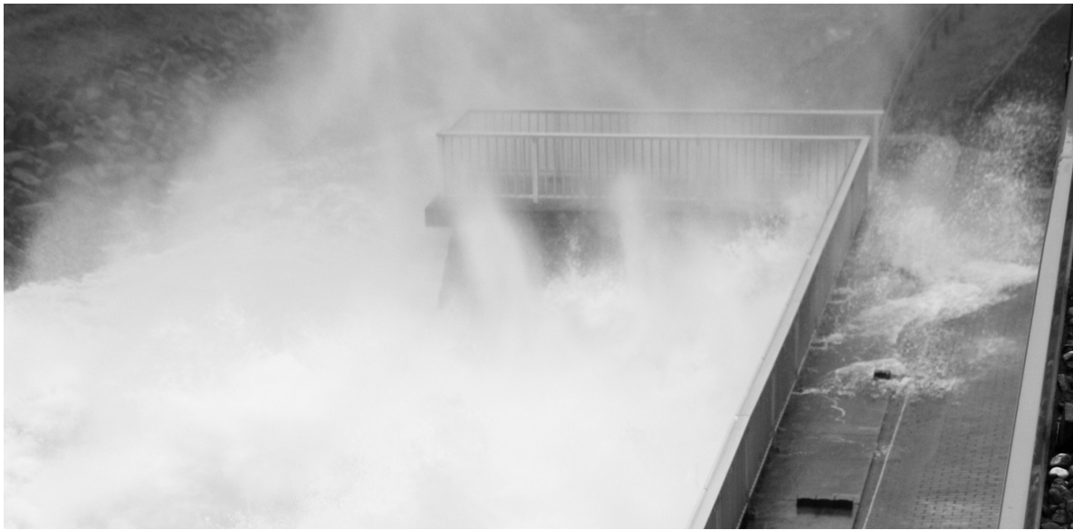
Abbildung 6: Übertretende Schwallwellen bei 70 %-iger Öffnung des GA 3
