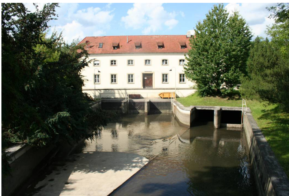
Abbildung 1: Schöpfwerk Straubing mit Ansicht von der Binnenseite, Pumpeneinläufe direkt unter dem Betriebsgebäude, rechts im Bild die Einläufe der freien Vorflut
