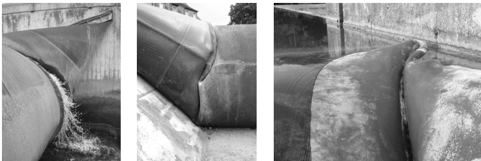
Abbildung 7: Schlauchwehre mit ausgeprägter Falte (Baiersdorf, Erlangen, Wertheim)
