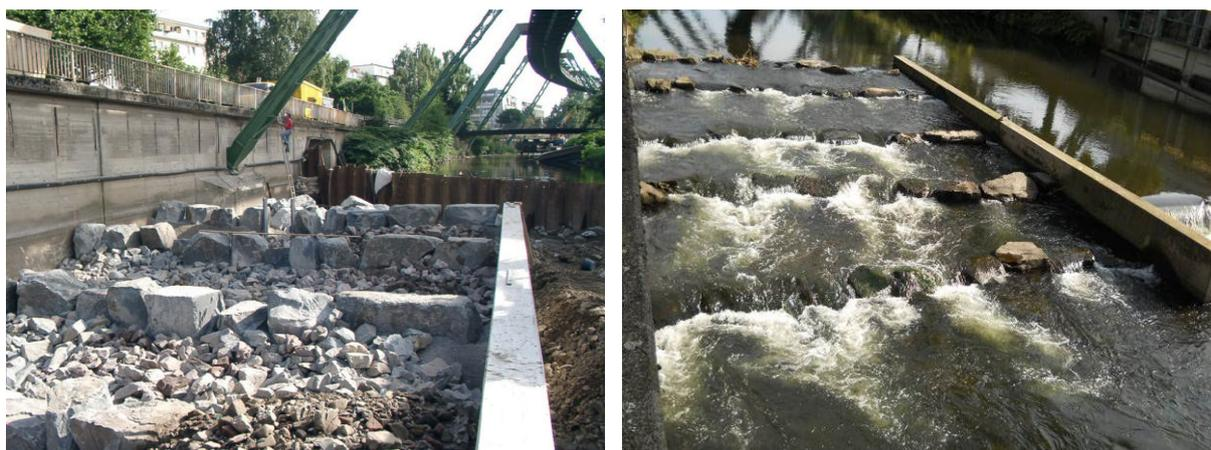
**Abbildung 1:** Foto einer zweigeteilten Blocksteinrampe in Riegelbauweise in Wuppertal Barmen, links: Bauzustand (Quelle: Wupperverband), rechts: Betriebszustand
