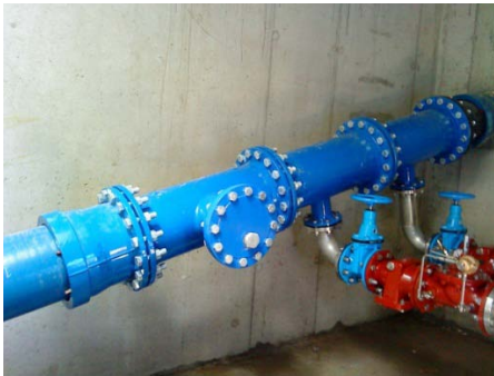
Abb. 6: Armatureschacht für mehrere Leitungsabhänge
