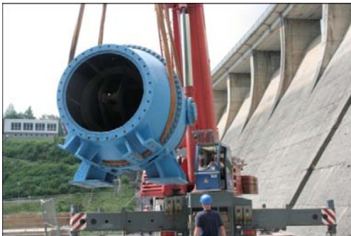
Abb. 7: Ausbau eines Ringkolbenventils DN 2000
