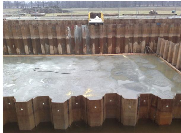
**Abbildung 9:** Baugrube nach dem Lenzen
