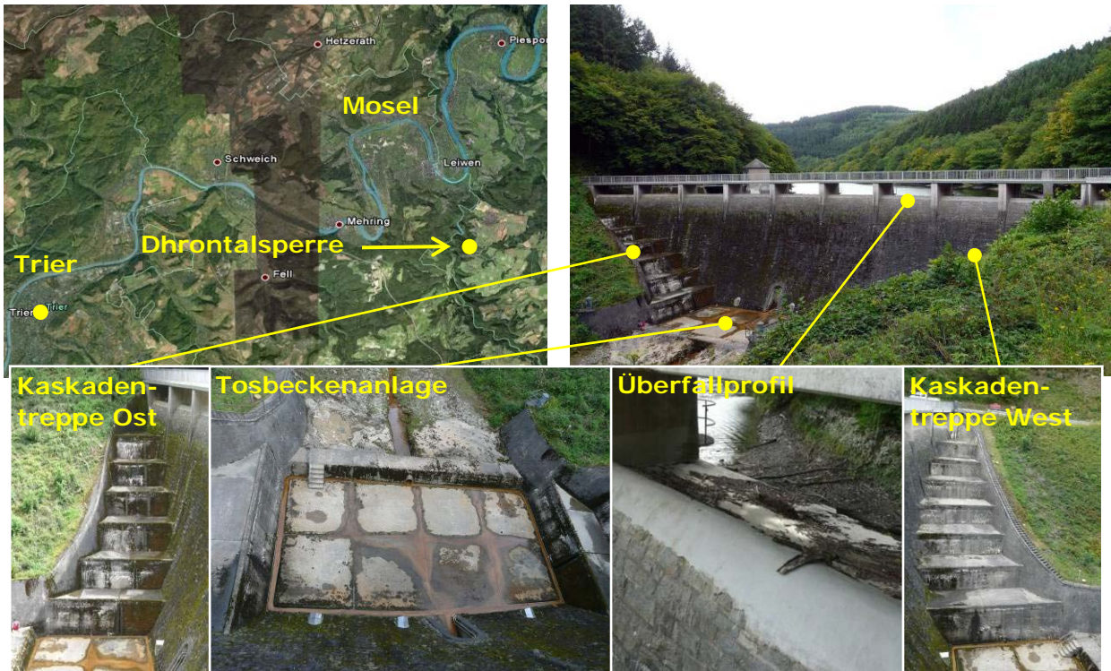
Abbildung 1: links oben: Geographische Einordnung der Anlage, rechts und unten: Ansicht Bauwerk mit Kaskadentreppen, Tosbecken und Überfallprofil
