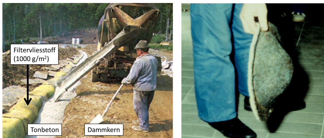
Abbildung 5: Herstellung der Tonbetondichtwand mit dickem vernadeltem Filtrervliesstoff (links) und verformter Vliesstoff bei projektspezifischen Untersuchungen zum Verformungs- und Bodenrückhaltevermögen (rechts)
