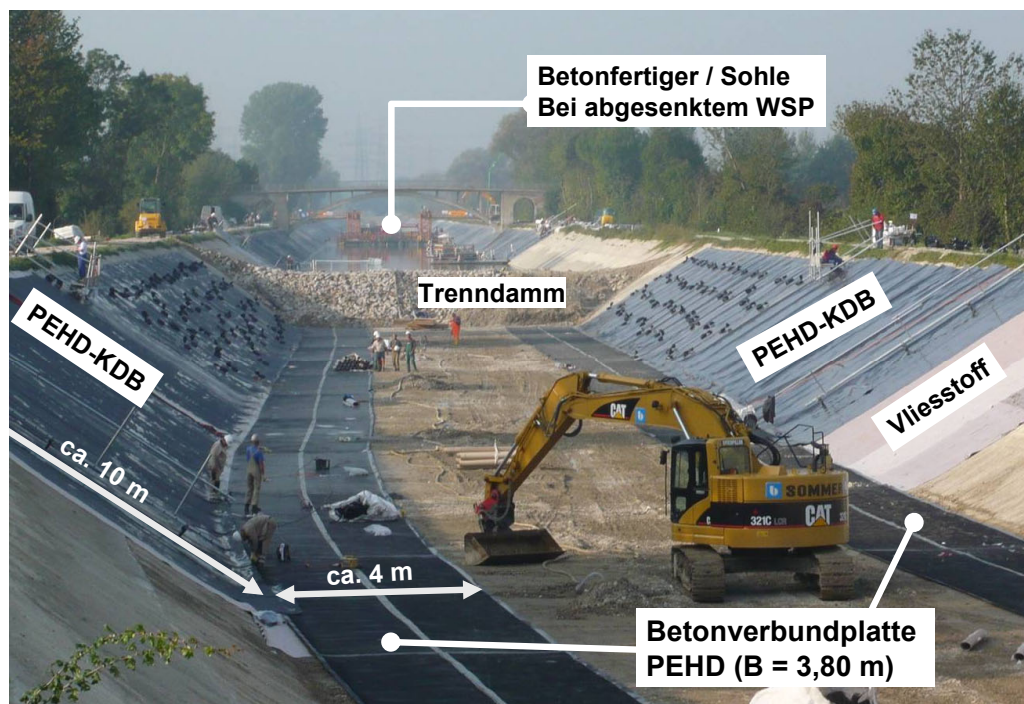
Abbildung 8: Ausführung der neuen KDB-Kanalauskleidung in Trockenbauweise und bei Teileinstau hinter dem Trenndamm.
