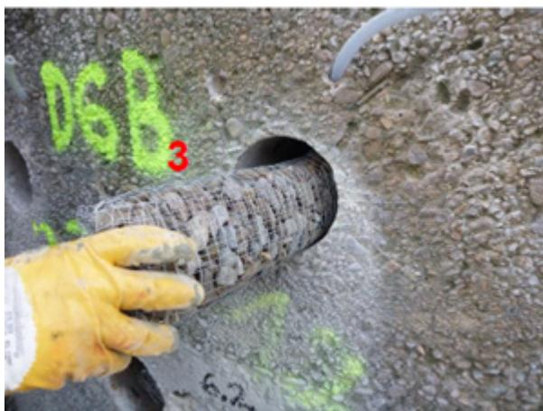
Abbildung 22: Einschieben eines mit Grobkorn gefüllten Drahtkorbs in ein Bohrloch an der Wehranlage Drakenburg
