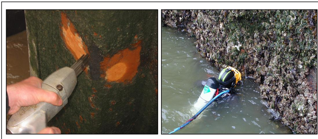
Abbildung 18: *Reinigung von Messstelle von Rost und Bewuchs*
