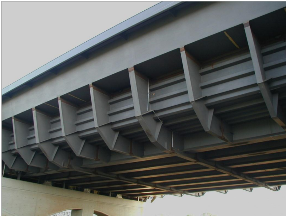
Bild 2: Untersicht der Vorlandbrücke der Kanalbrücke Magdeburg (einschiffiger Querschnitt)
