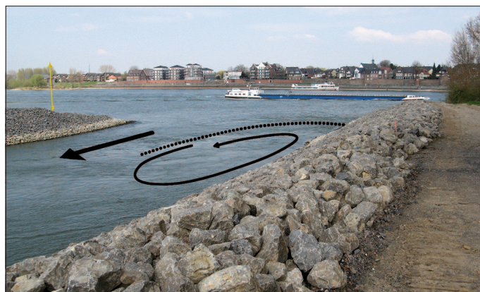
Bild 3.1: Fährschneise mit Blick in Richtung Stadt Rees Figure 3.1: View from ferry lane towards Rees
