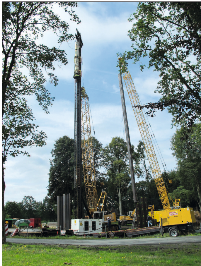
Bild 2.6: Proberammung (Rambbär und Mäkler) Figure 2.6: Driving test (hammer and leader)
