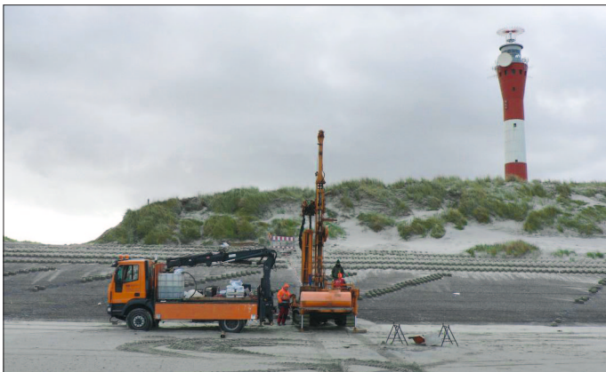
Bild 2.3: Einbau der Porenwasserdruckaufnehmer Figure 2.3: Installation of pore water pressure gauges
