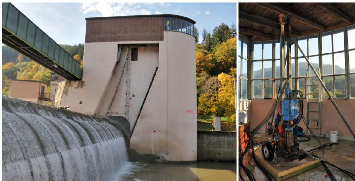
Bild 4: Wehr Rockenau/Neckar (links) und vertikale Kernbohrung durch den Wehrpfeiler (rechts)
