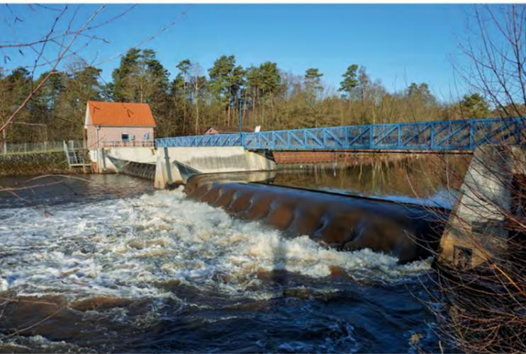
Bild 3: Schlauchwehr Bannetze an der Aller
