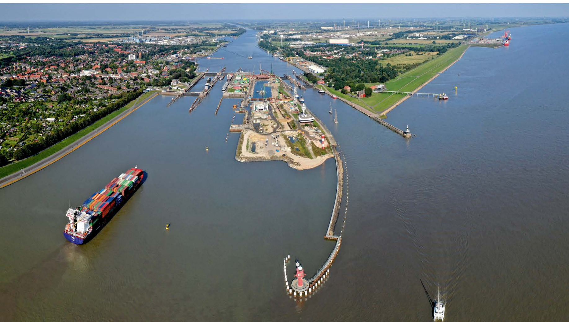
Bau der fünften Schleusenkammer Brunsbüttel
