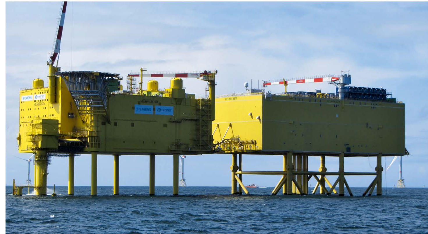
Bild 2: Die Konverterplattformen HelWin alpha und beta mit unterschiedlichen Jacketgründungen, Nordsee
