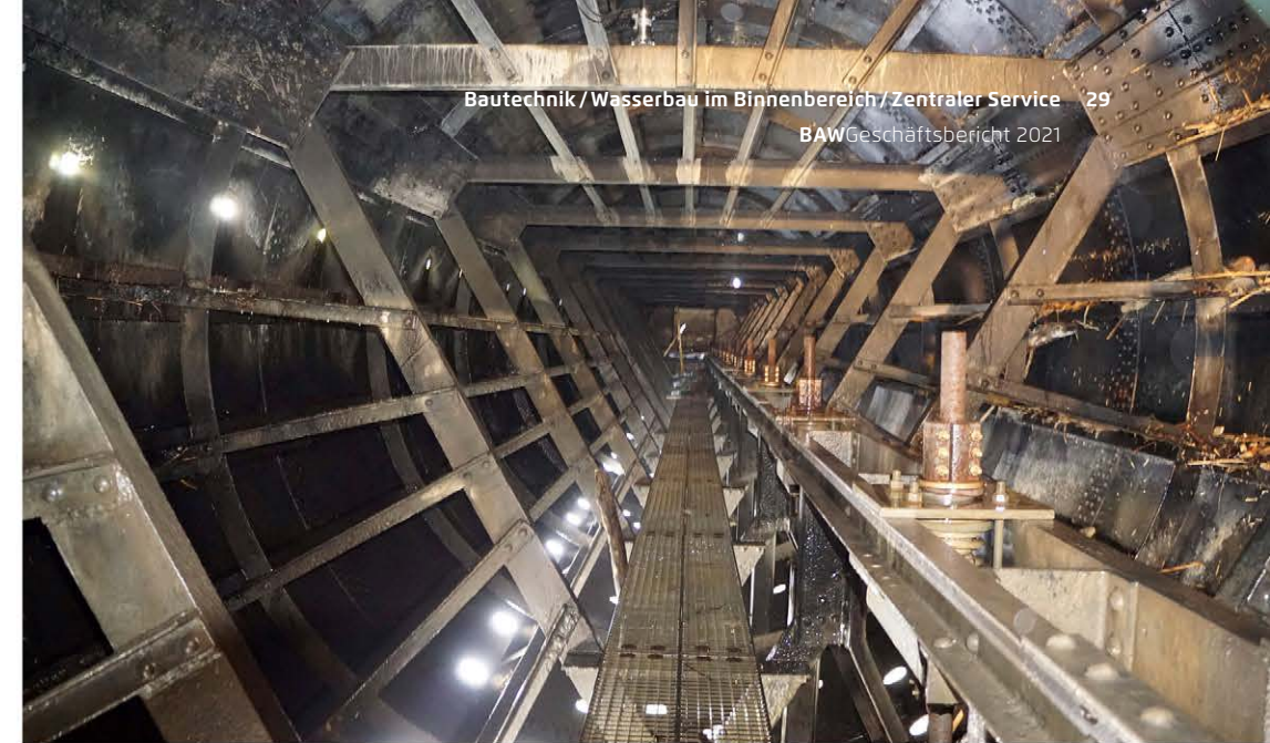
Bild 5: Versenkwalze mit Federgestänge
