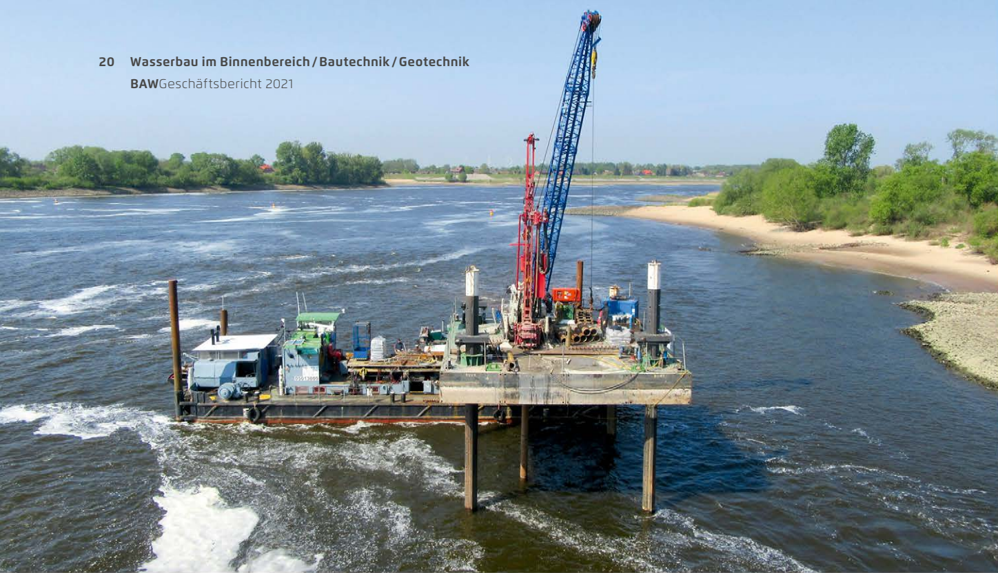
Bild 4: Baugrunderkundung im Unterwasser; die Tide erfordert den Einsatz eines Hubpontons
