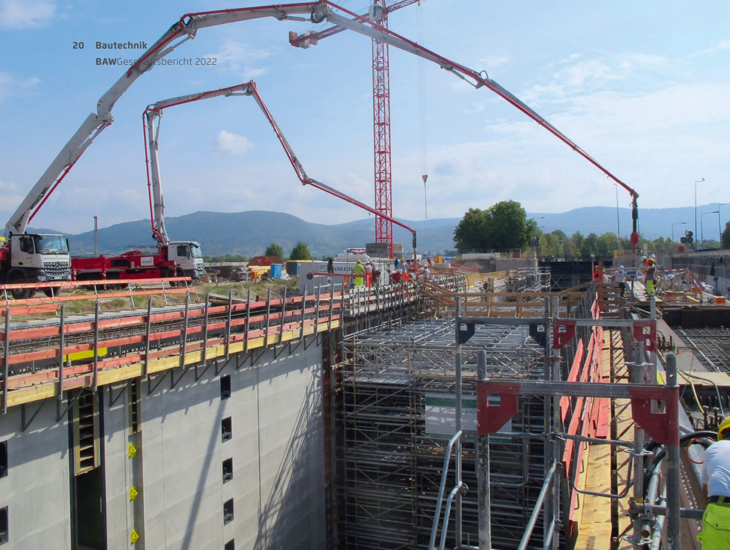
Bild 3: Betonage der Betonvorsatzschale an der Schleuse Schwabenheim (Juli 2022)
