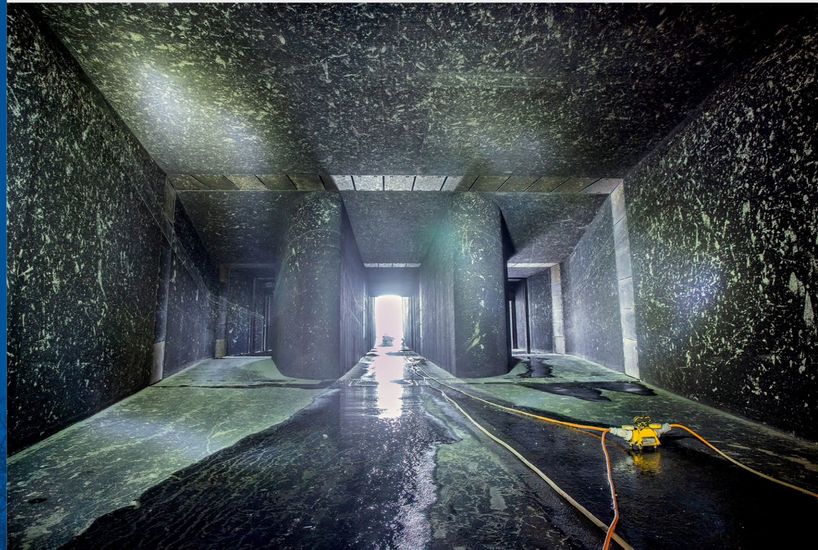
Sparbeckenlauf in das Grundlaufsystem der Schleuse Hohenwarthe während der Trockenlegung
