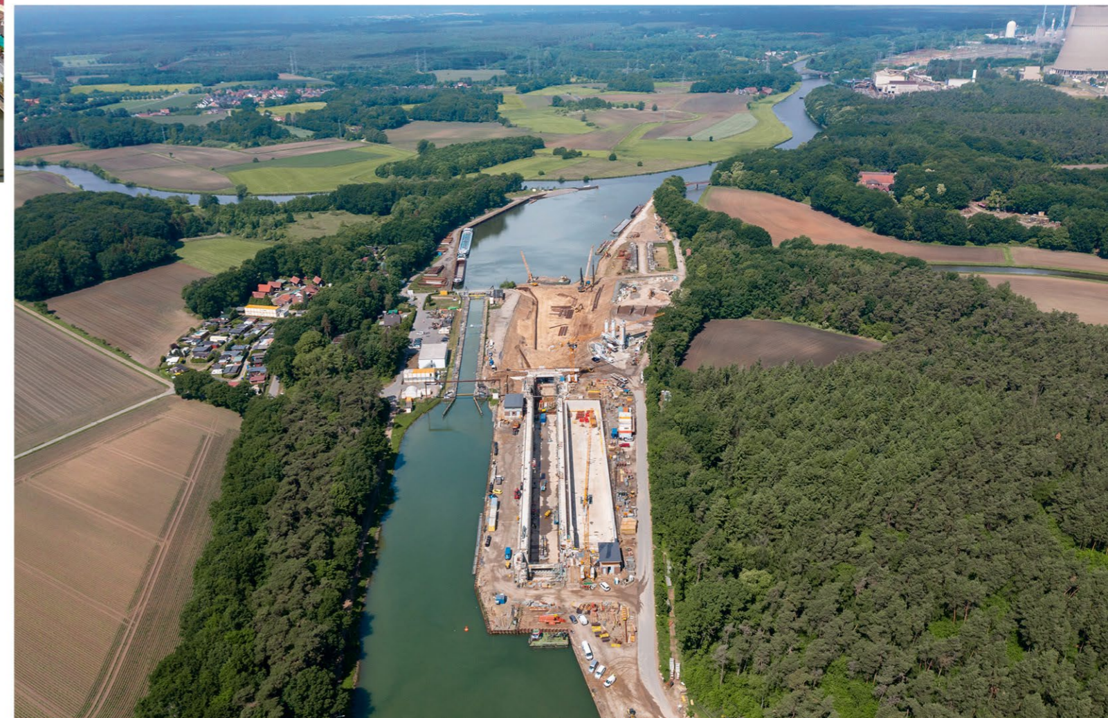
Neubau der Schleuse Gleesen (Dortmund-Ems-Kanal)
