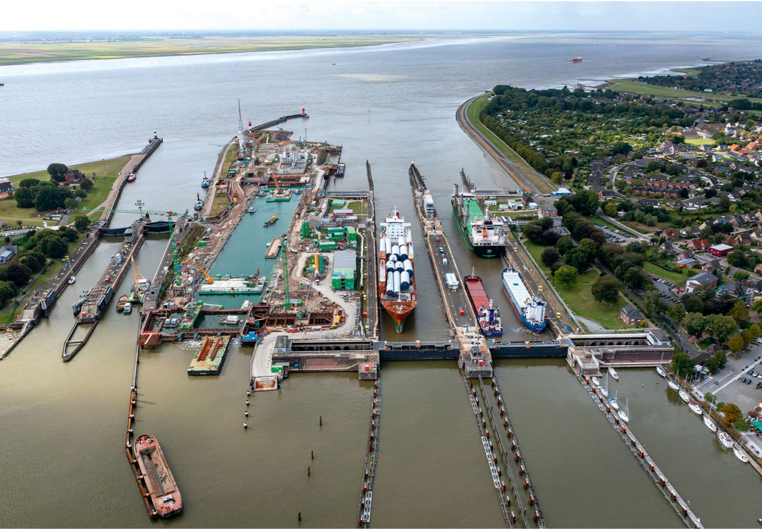
Bau der fünften Schleusenkammer Brunsbüttel (Nord-Ostsee-Kanal)
